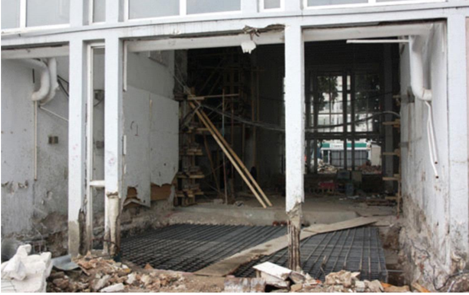
Şekil 4.33: Güçlendirme Çalışmaları Sırasında Rıhtımdan Osman Hamdi Bey Salonu'na bakış ( http://www.mimdap.org/wp-content/uploads/h37.jpg )
