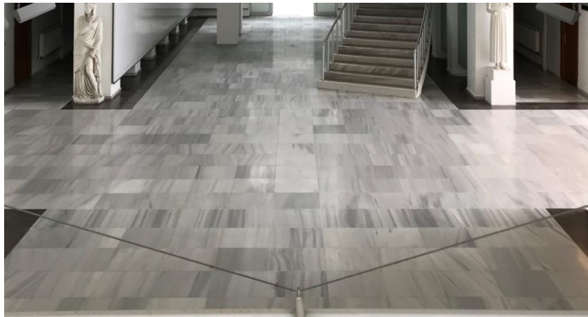
Şekil 4.104: Osman Hamdi Bey Salonu Zemin döşemesi (Yunus Albayrak Arşivinden)
