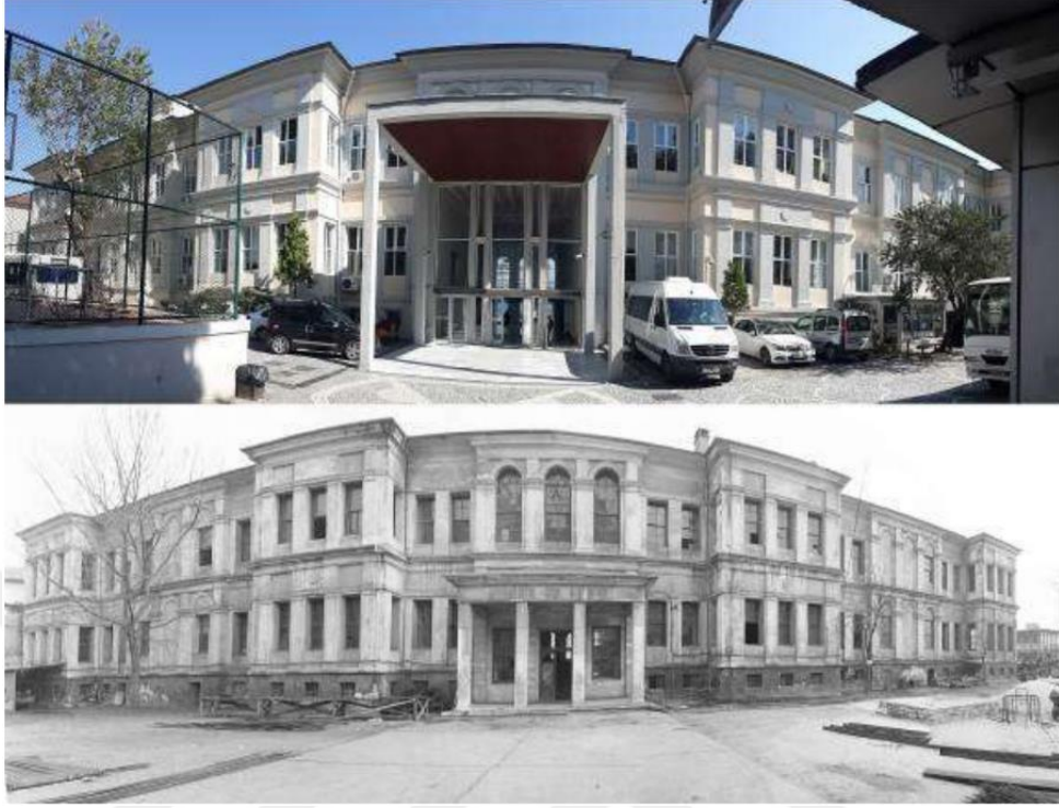
Şekil 4.43: Mürşit Sultan (Atatürk Kız lisesi) girişinin sırasıyla Müdahale öncesi ve sonrası fotoğrafları (Binan, Töre ve Kut, 2013)
