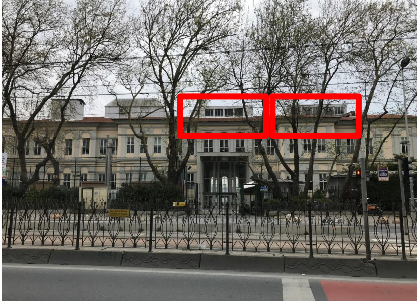
Şekil 4.48: Çatı fenerleri Meclis-i Mebusan Caddesinden görünüşü (Yunus Albayrak Arşivinden)
