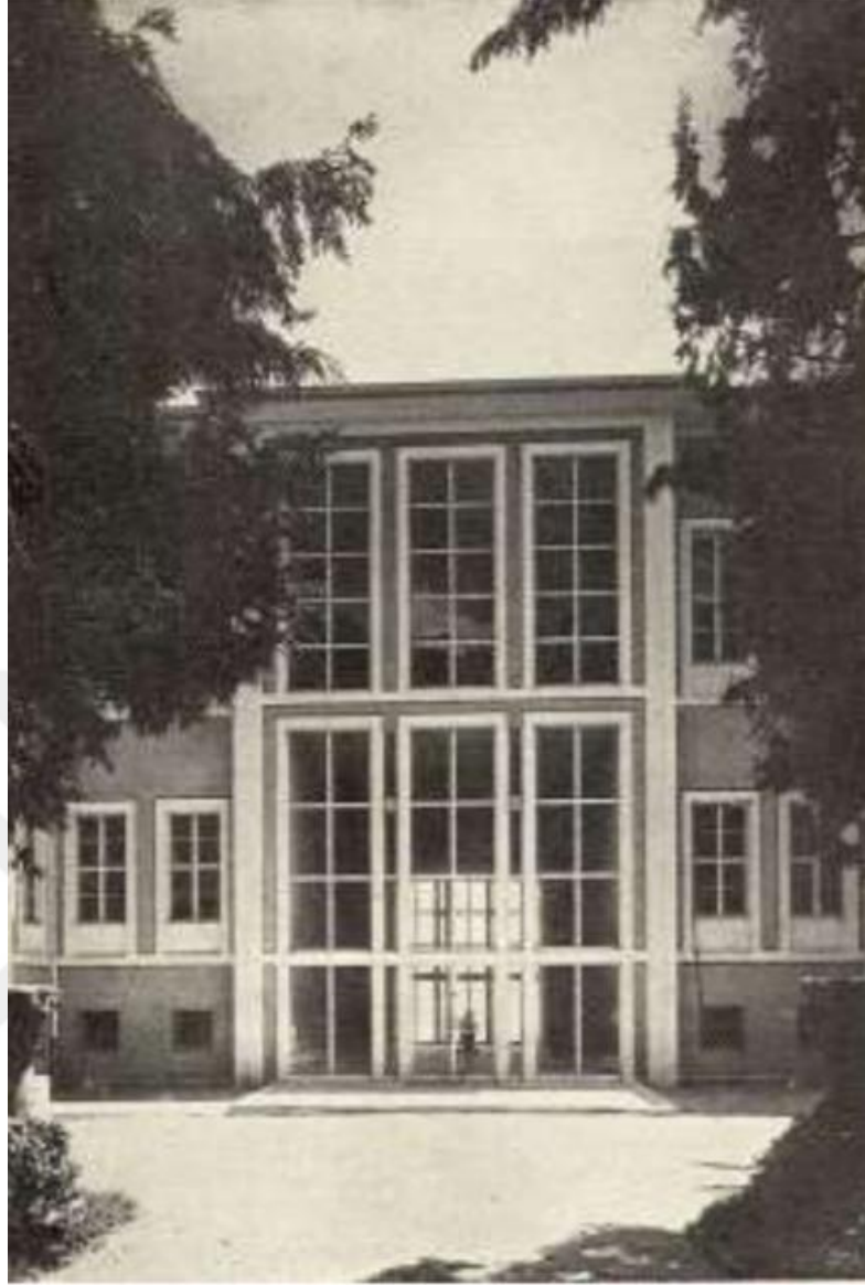
Şekil 4.22 : Onarım sonrası Güzel Sanatlar Fakültesi girişi (Eldem ve Handan, 1954)
