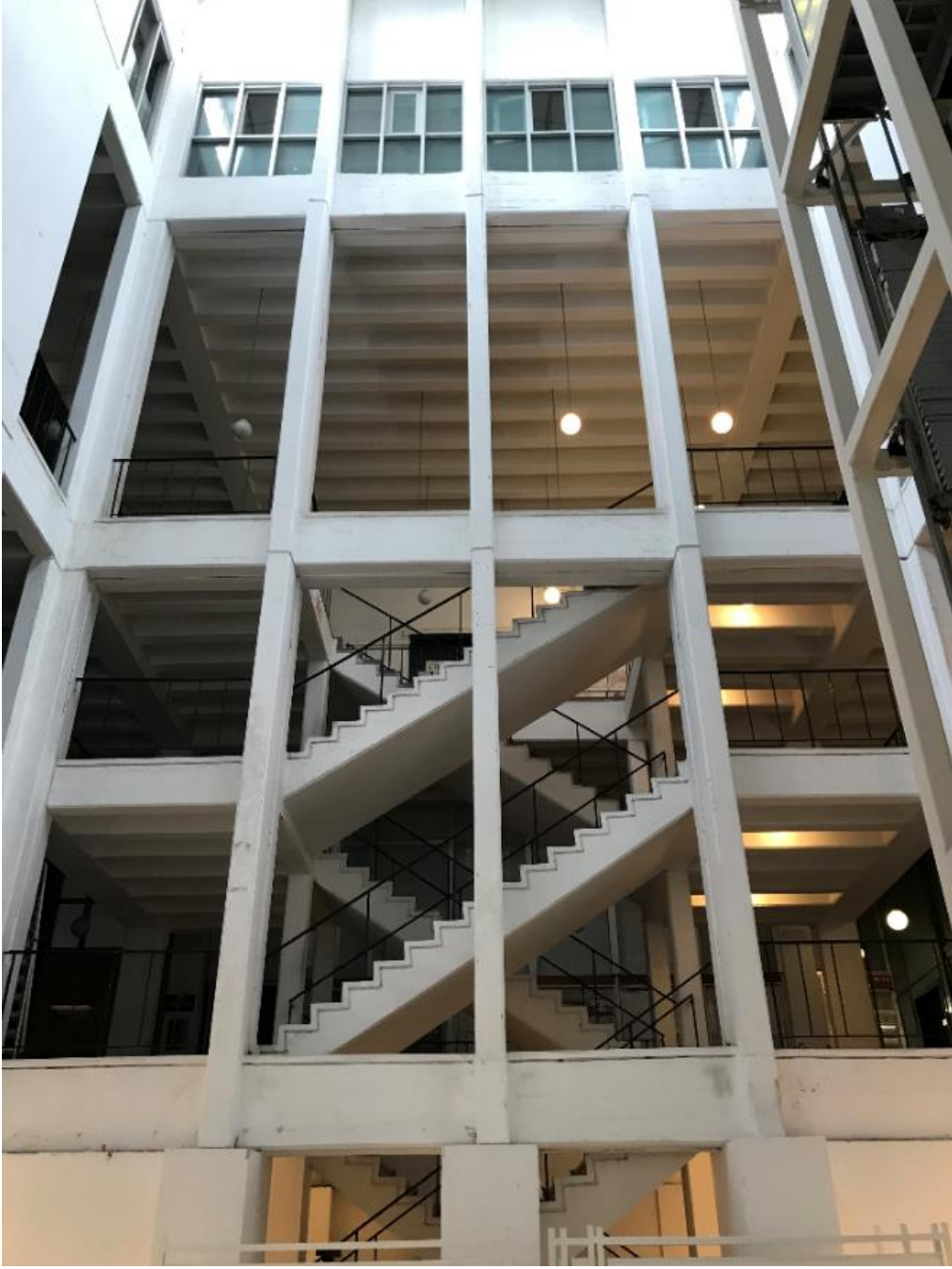
Şekil 4.107: Mimarlık Fakültesi koridorlarının gün içinde yapay aydınlatma ile solda aydınlatılmadığı sağda aydınlatıldığı görünümü (Yunus Albayrak Arşivinden)
