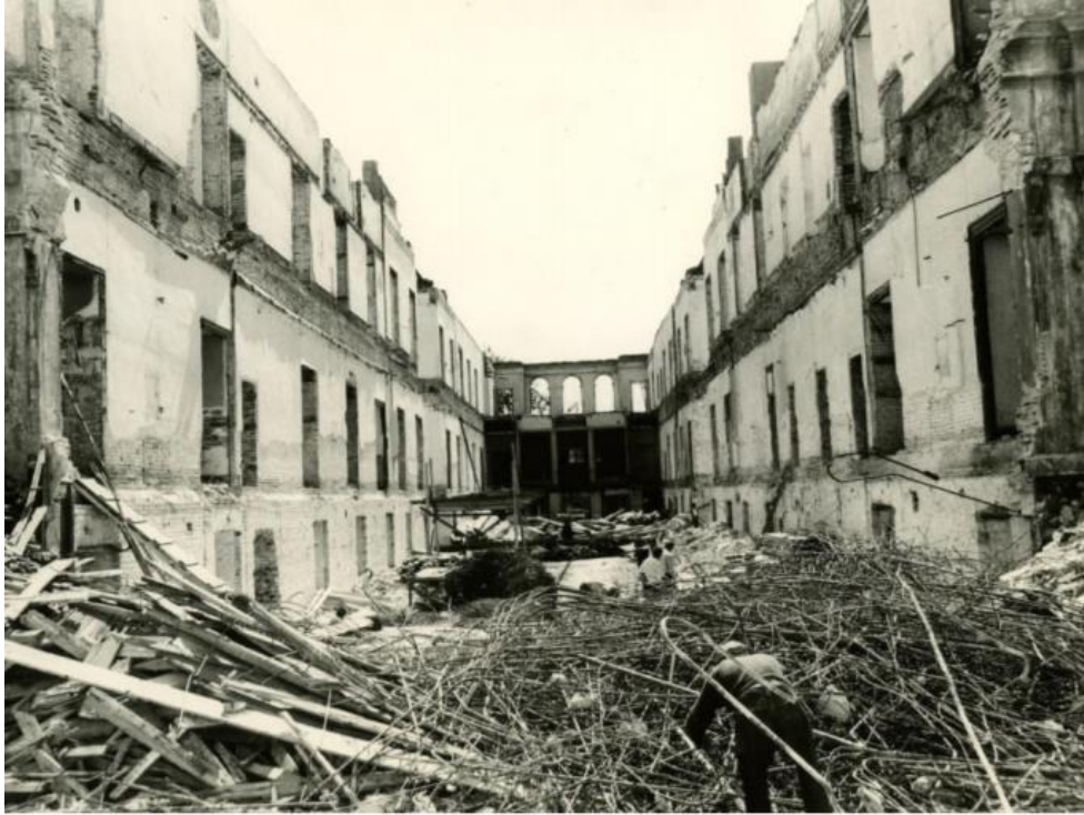
Şekil 4.44: İnşaat sırasında Mürşit Sultan Sarayı'ndan Karaköy yönüne doğru bakış (MSGSÜ Mimarlık Bölümü Restorasyon A.D. Arşivi).
