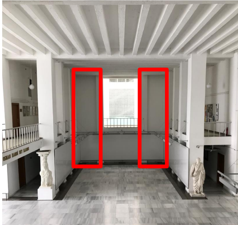
Şekil 4.32: Güçlendirme uygulaması sonrası Osman Hamdi Bey Salonu'nda Karaköy yönündeki iç avluya bakış (Yunus Albayrak Arşivinden)
