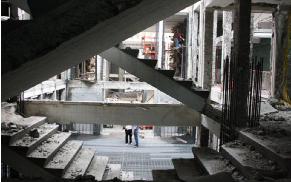
Şekil 4.34: Güçlendirme Çalışmaları Çapraz Merdivenlerden Karaköy yönüne bakış ( http://www.mimdap.org/wp-content/uploads/ha113.jpg )
