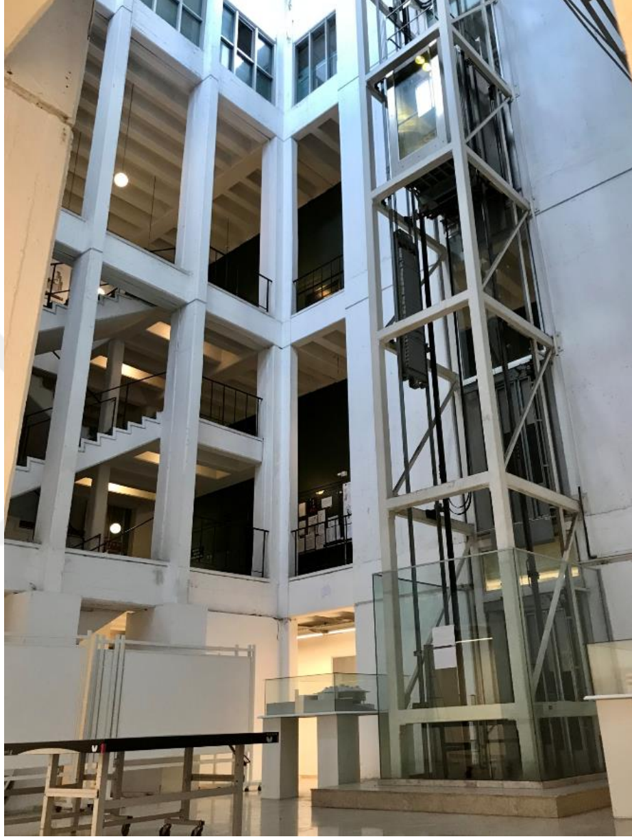
Şekil 4.63: Düşey iç boşluk içerisine eklenen asansör (Yunus Albayrak Arşivinden)
