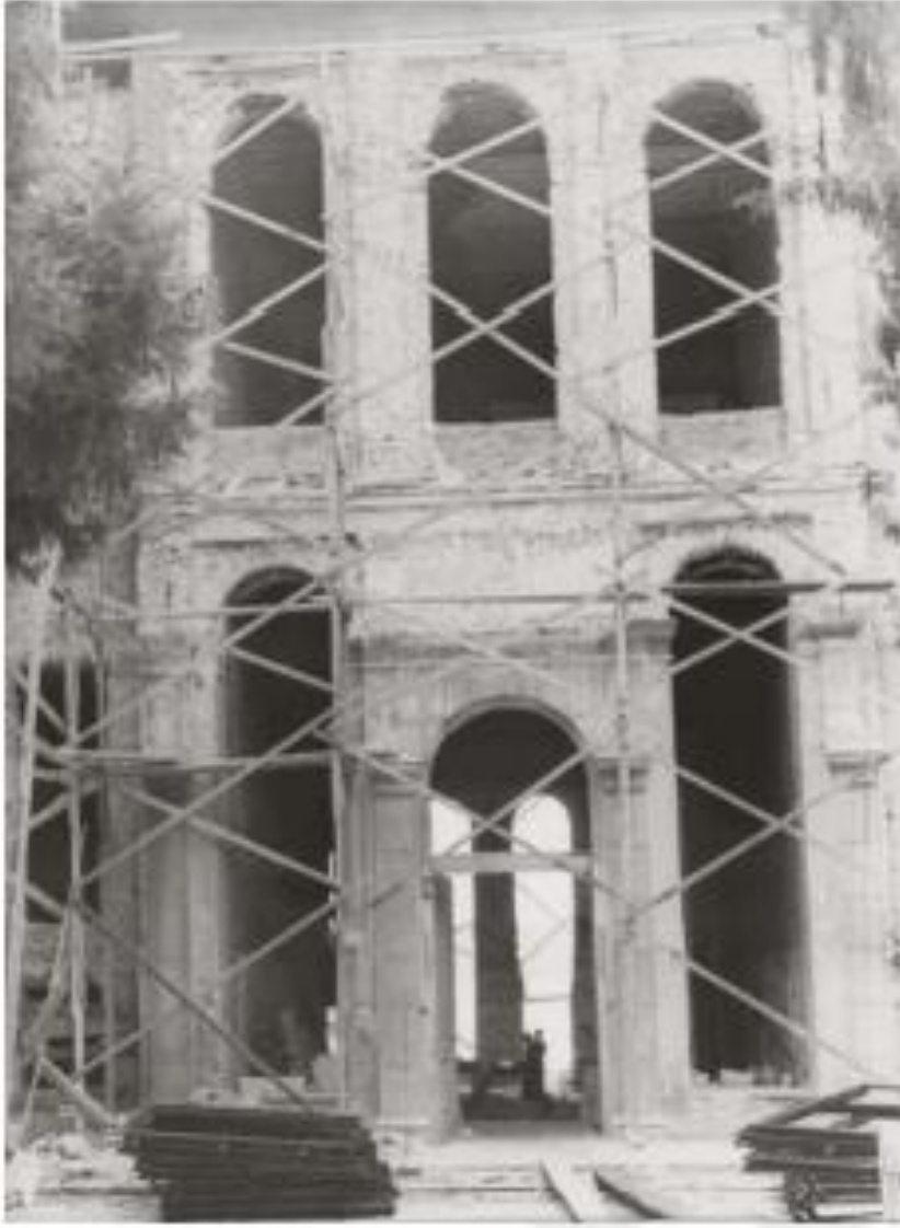
Şekil 4.21 : Onarım sırasında giriş cephesinin görünüşü (MSGÜ Rektörlük Fotoğraf Atölyesi Arşivi).
