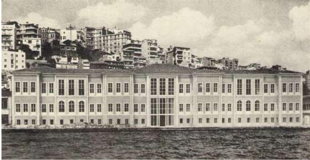
Şekil 4.25 : Yenileme Sonrası Cemile Sultan Sarayı Boğaziçi Cephesi (Sedad Hakkı Eldem ve Handan, 1954)
