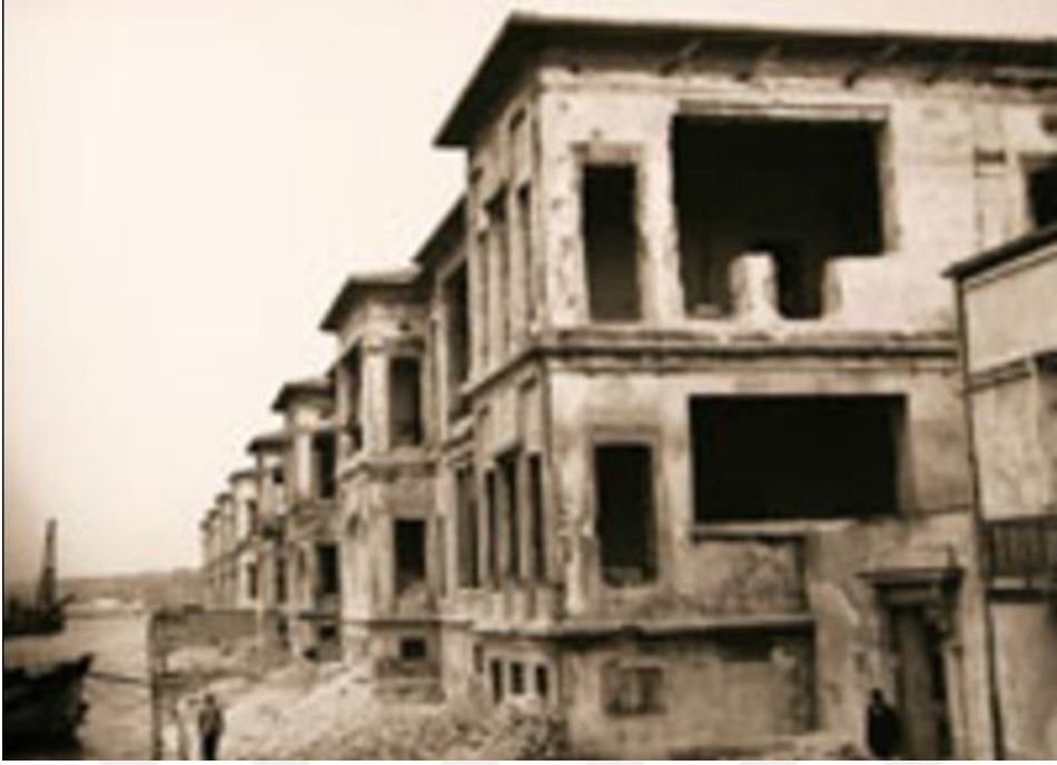
Şekil 4.6 : Cemile Sultan Sarayı Yangın Sonrası Hali. (Binan, Töre ve Kut, 2013)
