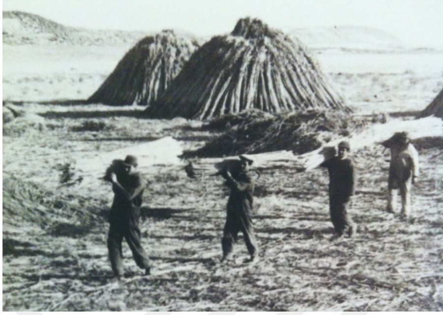
Şekil 1.1. Rüzgar erozyonu kontrol çalışmaları başlangıcı, Karapınar-1962 (kamış perdelerin taşınma ve tesisi. Resim Konya Toprak Su ve Erozyonla Mücadele Araştırma İstasyonu arşivinden sağlanmıştır).
