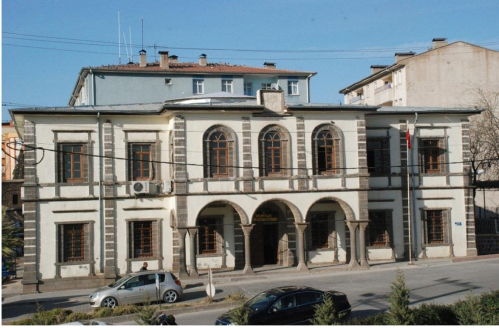
Foto 4. 2: 1906 Yılında Yapımı Biten ve Günümüzde İlçe Halk Kütüphanesi Olarak Kullanılan Eski Vilayet Konağı.
