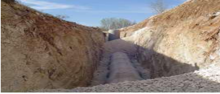
Fotoğraf 5.13. Atık Su Arıtma Tesisi İnşaatı.
