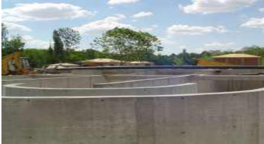
Fotoğraf 5.12. Oğuzeli-Yeşildere Ana Kollektör Hattı Yapımı.
