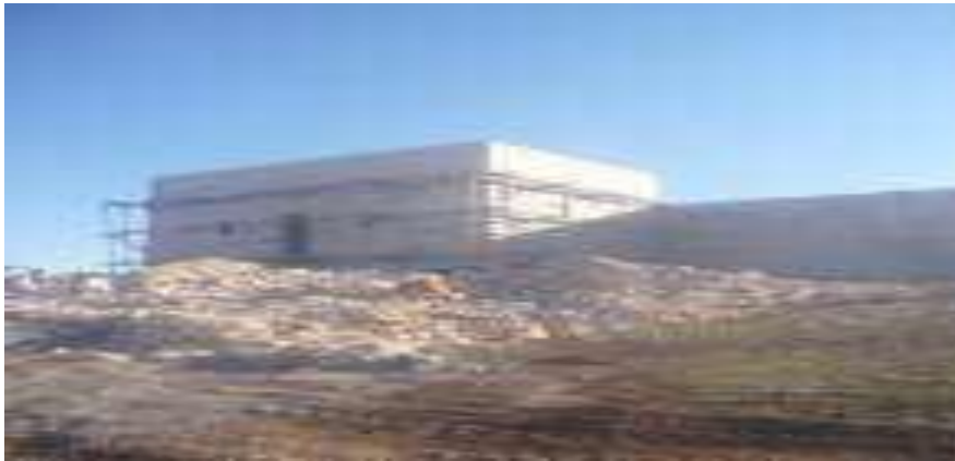
Fotoğraf 5.14. Oğuzeli Terfi Hattı ve Terfi Merkezi Yapımı.
