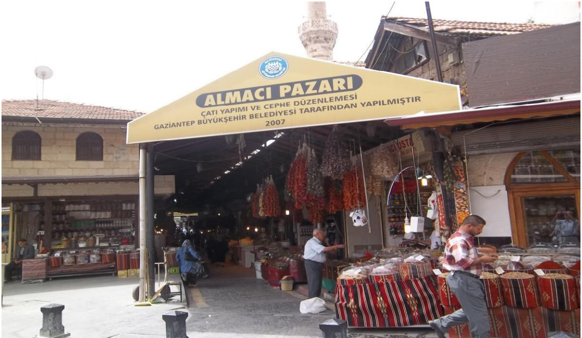
Foto 20.2. Almacı Pazarı;Şekeroğlu Mahallesi Eski Saray Caddesi üzerindedir.
