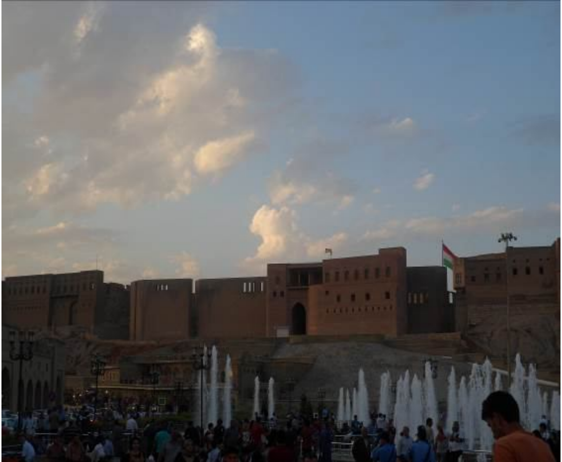
Foto 3.1. Erbil Kalesi'nin güney kapısı
