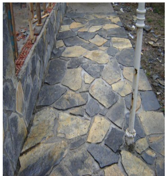
Şekil 3.48. Kayrak Taşı Döşeme
