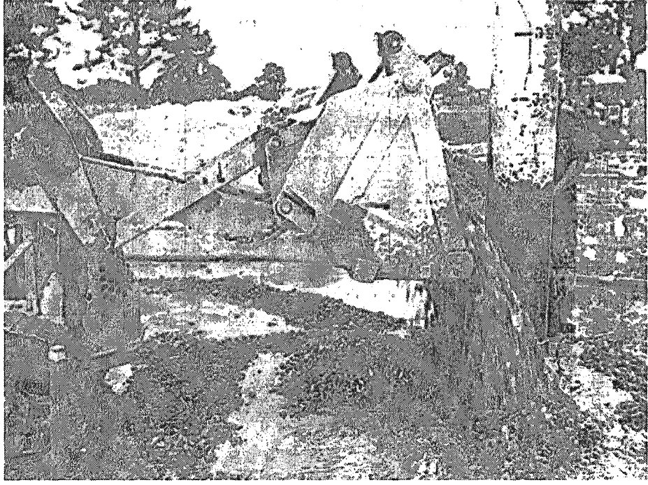
Şekil 2.4. Kazı Çukurunun Doldurulması (6)
