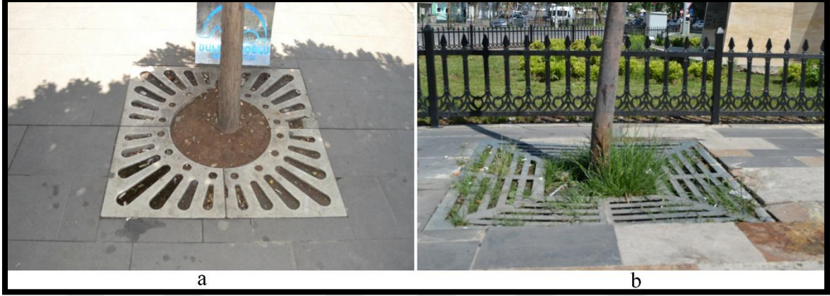
Şekil 4. 65. Trabzon Caddesinde ağaç altı ızgara donatıları (a: prekast malzeme, b: çelik malzeme)
