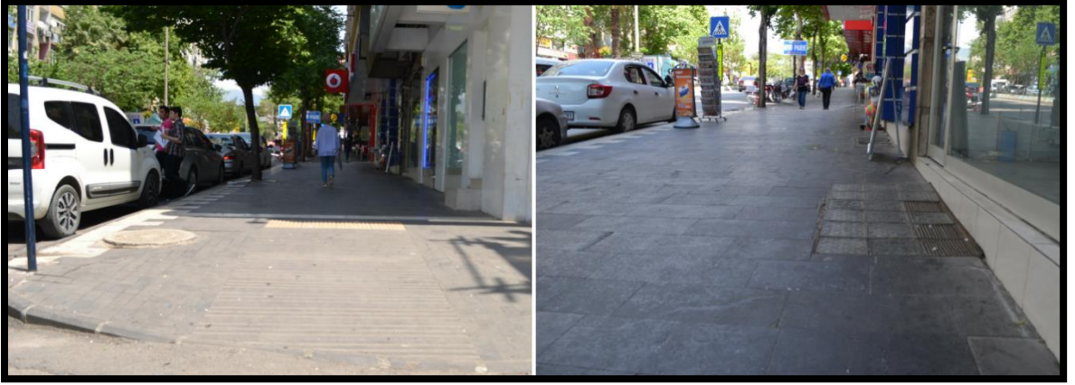
Şekil 4. 37. Hükümet Caddesi engelli rampasının rampa başında yer alırken devamında olmaması
