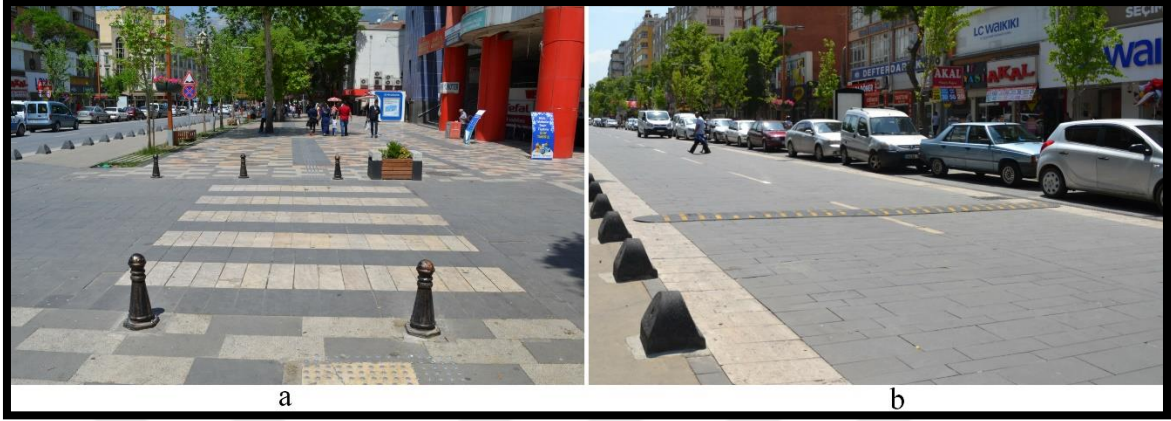
Şekil 4. 34. Trabzon Caddesinde yeni düzenlenen alan içerisinde döşeme kaplamaları (a: yaya geçişleri, b: araç yolu)
