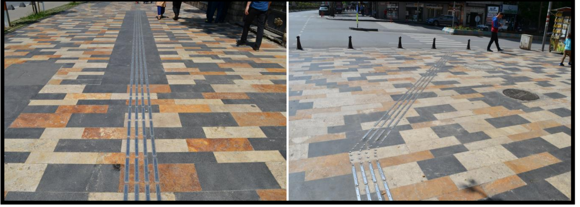
Şekil 4. 38. Görme engelliler için tasarlanmış şerit akslar
