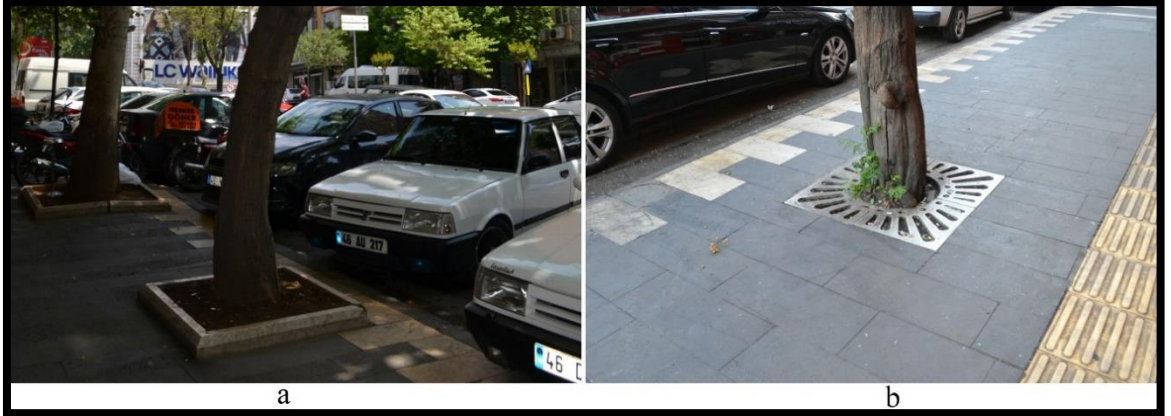
Şekil 4. 66. Hükümet Caddesinde ağaç altı ızgara donatıları (a: bordür taşı, b: prekast malzeme)
