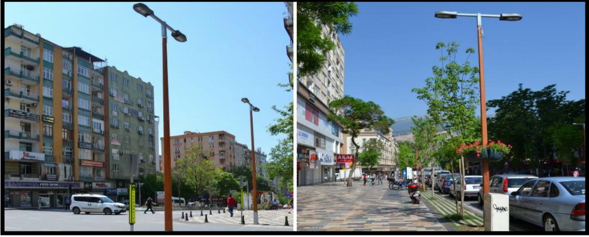
Şekil 4. 1. Trabzon Caddesinde yeni düzenlenen alanda yer alan aydınlatma donatıları
