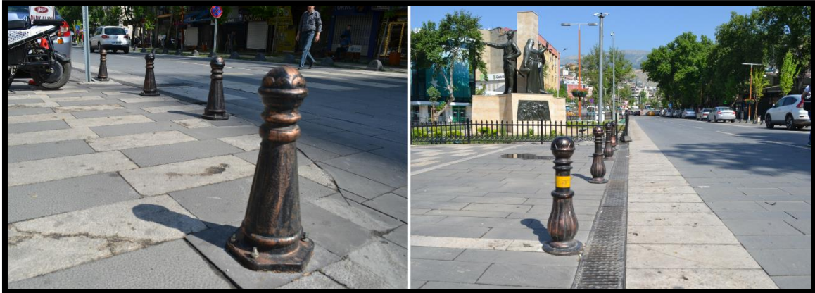
Şekil 4. 40. Trabzon Caddesinde metal malzemeli trafik engelleyici sınırlayıcılar
