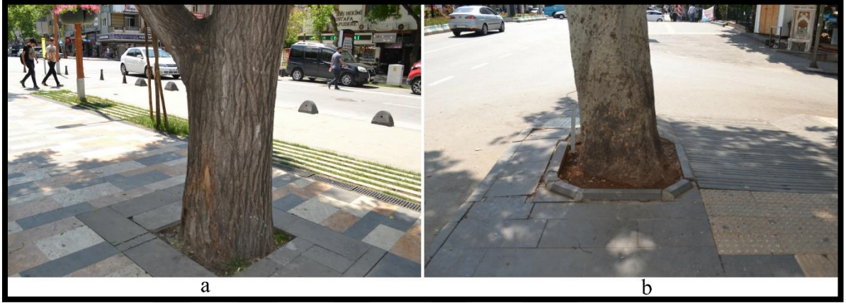
Şekil 4. 64. Trabzon Caddesinde ağaç altı ızgara donatıları ( a : zemin döşeme malzemesi, b : bordür taşı)
