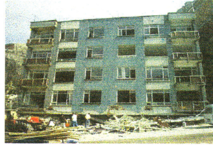
Foto-10 Yıkılmış bina
