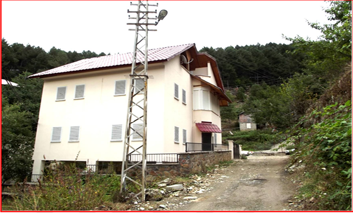
Foto 4.3. Zorkun Yaylasında inşa edilmiş modern betonarme konut.
