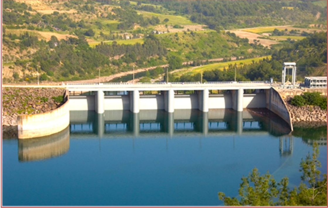
Foto 3.7. Kadirli ilçesinde yer alan Aslantaş Barajından genel bir görünüm. (Osmaniye İl Kültür ve Turizm Müdürlüğü (2015).
