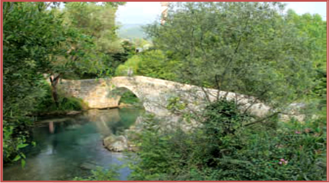
Foto 4.119. Sumbas ilçesi Gaffarlı köyündeki Taş Köprü'nün restorasyon sonrası görünümü. (Tülek, 2014: 47).
