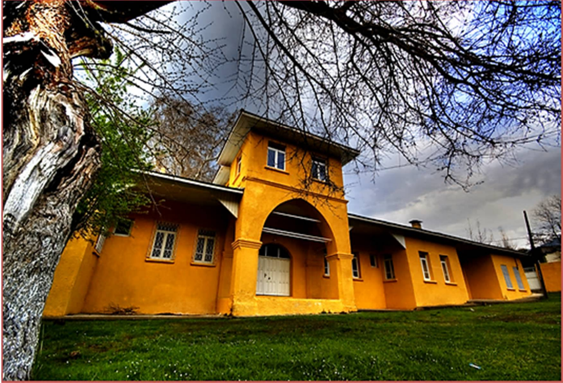
Foto 4.12. Yarpuz (Cebel) Köyünde Sancak merkezi olduğu dönemine ait restore edilmiş hükümet konağı. (Osmaniye Belediyesi arşivinden alınmıştır (2015).
