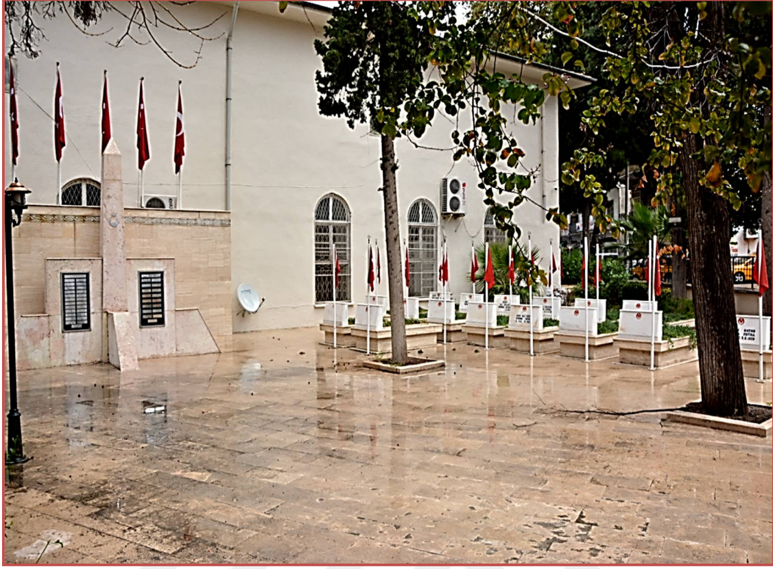
Foto 4.88. Envar-ül Hamit Caminin güney cephesinde yer alan Kurtuluş Savaşı dönemi Şehitleri için yapılmış Şehitlik alanı ve abidesi.
