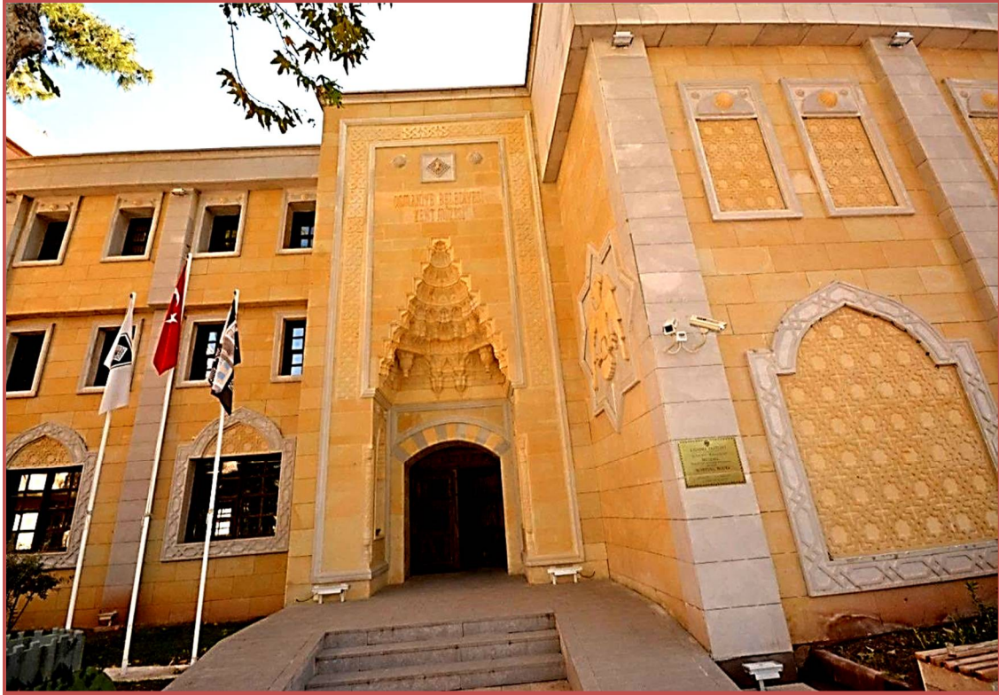
Foto 4.105. Kent Müzesinin Mukarnas Giriş Kapısı ve Selçuklu Mimarisine uygun olarak dış cephesine yapılan taş kaplamadan bir görünüm.
