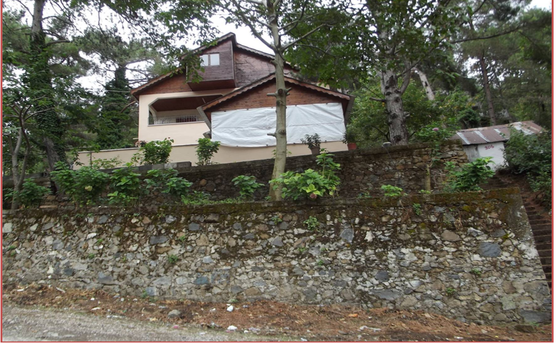
Foto 4.8. Olukbaşı Yaylasında ilk katı betonarme ikinci katı ahşap olan konutlar.
