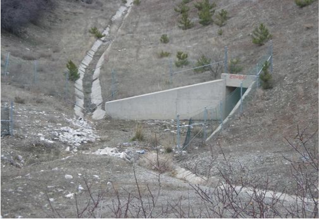
Şekil 3.5- 3.6: Menfez Girişindeki Toplanma Havuzlarının Geniş Tutulması
