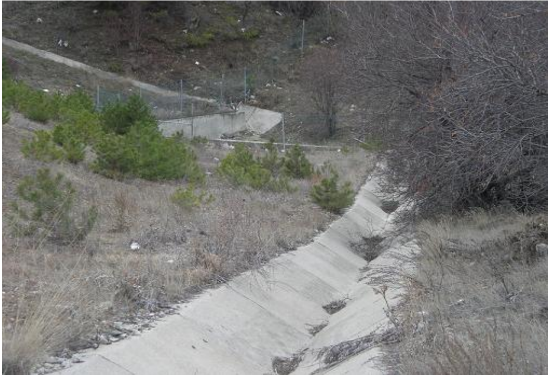
Şekil 3.15: Tüm Hendeklerden, Borulardan, Bordür ve Düşüm Oluklarından ve Bacalardan Gelen Suların Bir Yerde Toplanması
