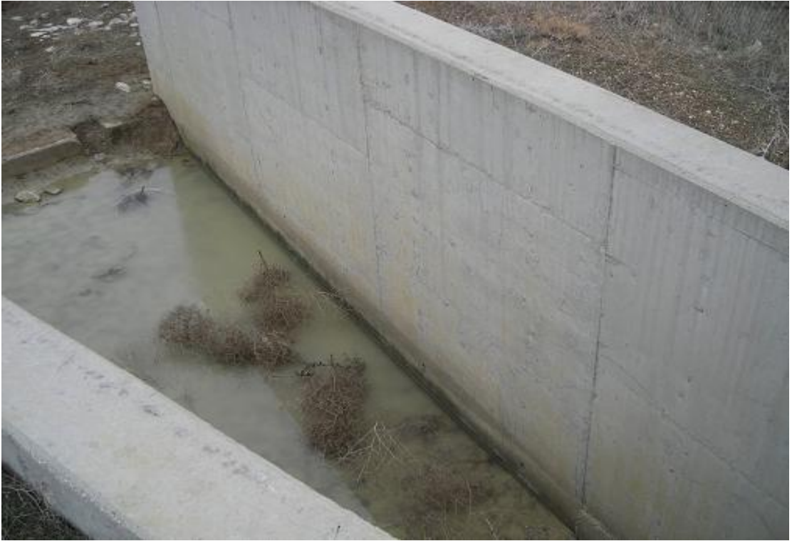
Şekil 3.3: Menfez Girişindeki Kanat Duvarlarının 200 Dozlu Betondan Yapılması
