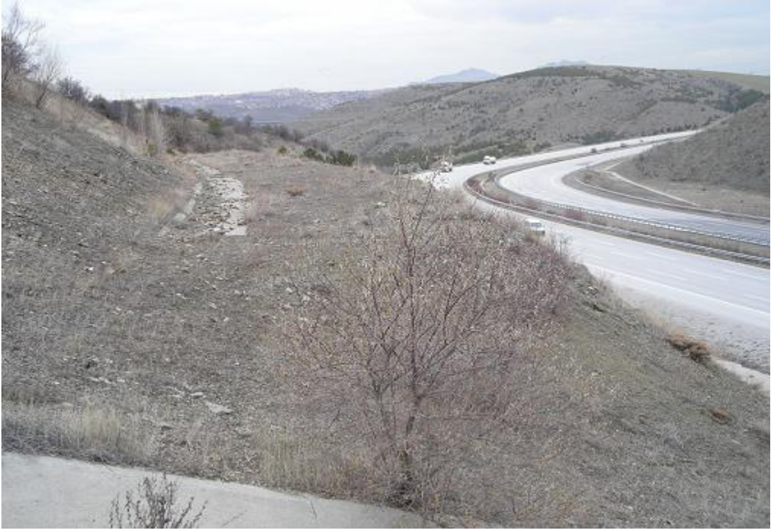
Şekil 3.4: Palye Hendeklerinin Tıkanarak Verimli Arazilerin Zarar Görmesi
