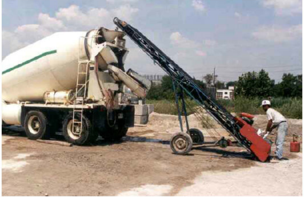
Şekil 1.10. Şantiyede Elle Transmiklere Ekleme
