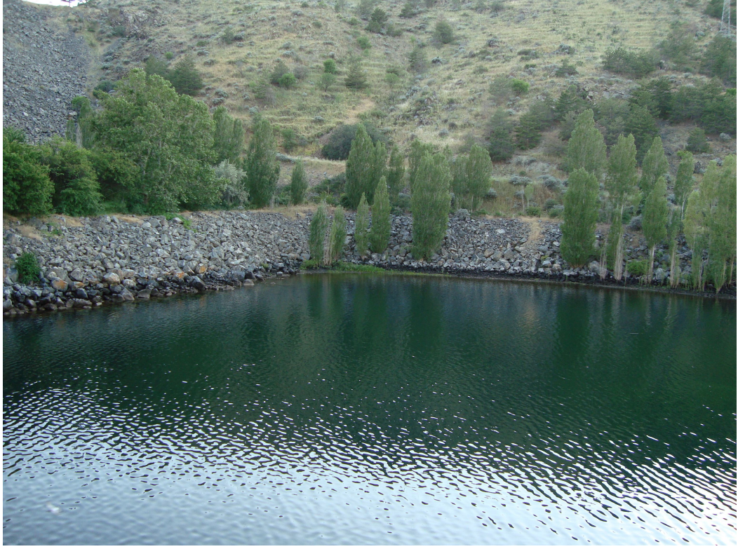
Şekil 3.4. Baraj setinden sonra (mansap) kıyılarda yapay kayalıklardan oluşan su samuru habitatı
