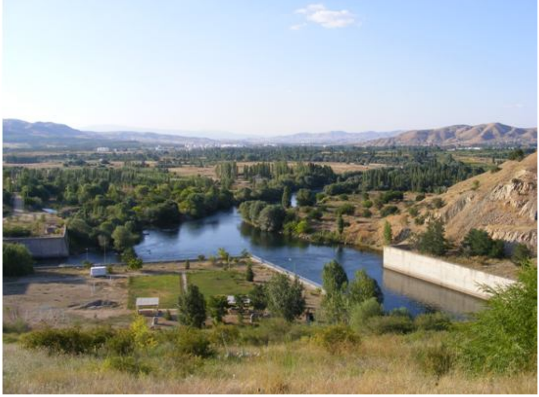
Şekil 3.20. Su samurunun tespit edildiği Kapulukaya Barajı'nın mansabı
