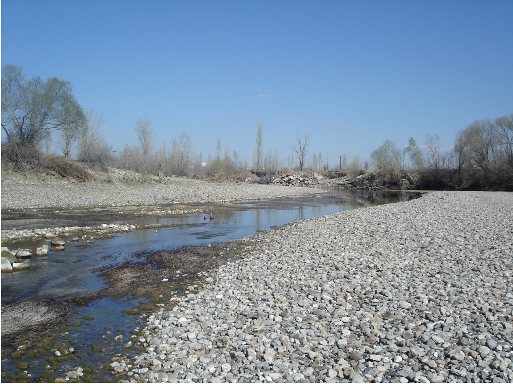
Şekil 3.34. Suyun barajda tutulması sonucu nehir yatağının görünümü
