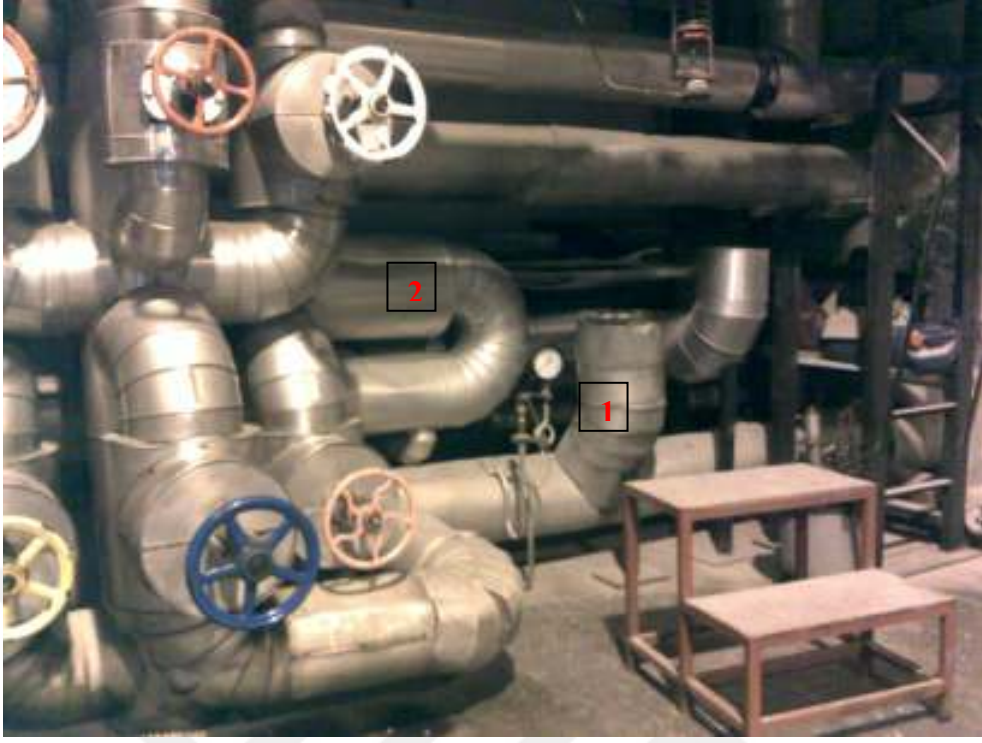
Şekil 11 Ejektör montaj yeri
