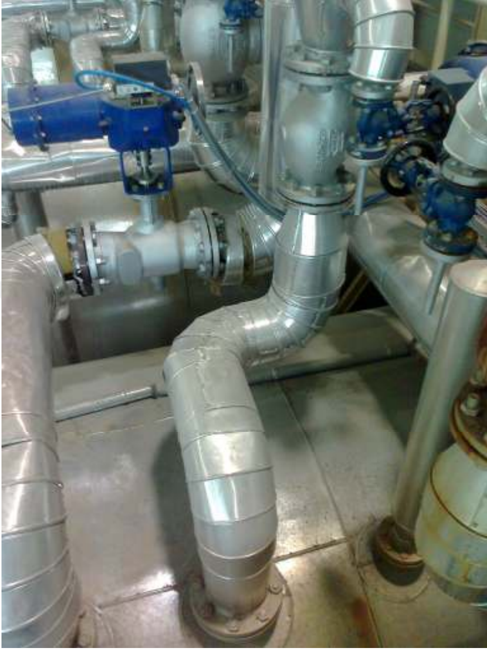
Şekil 5 Otoklav çıkışından ejektöre giriş kontrolü
