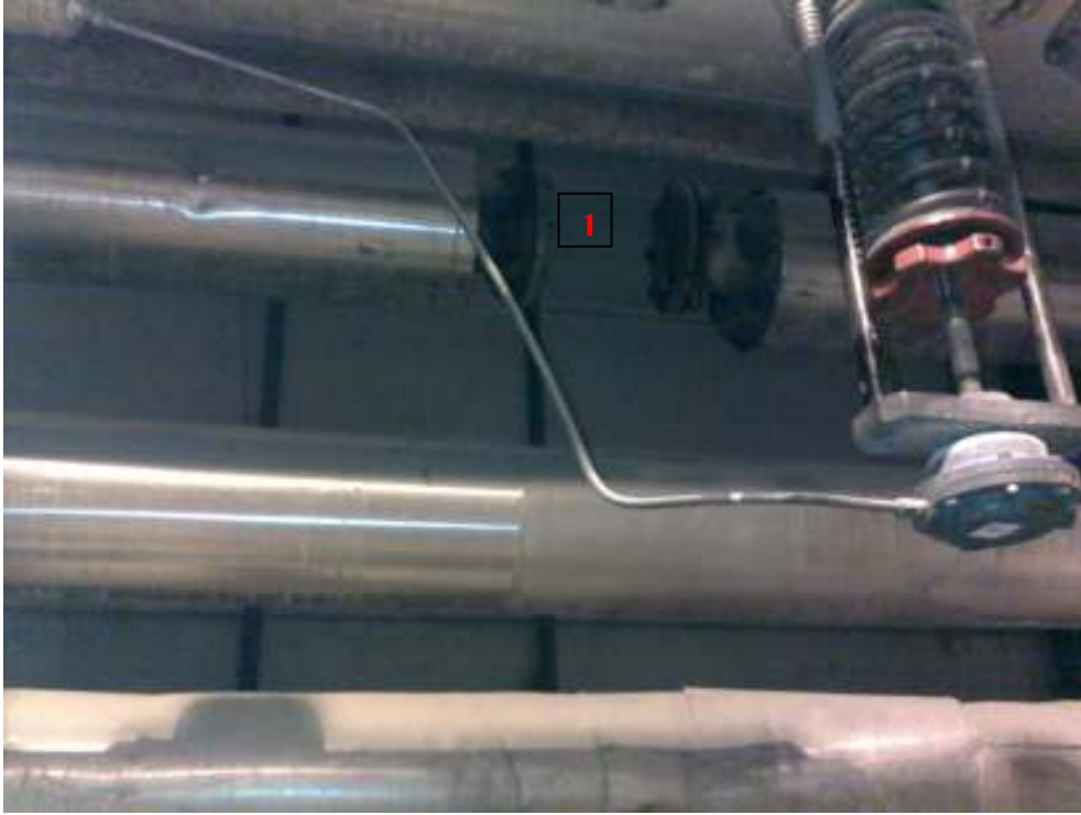
Şekil 12 Ejektör montaj yeri
