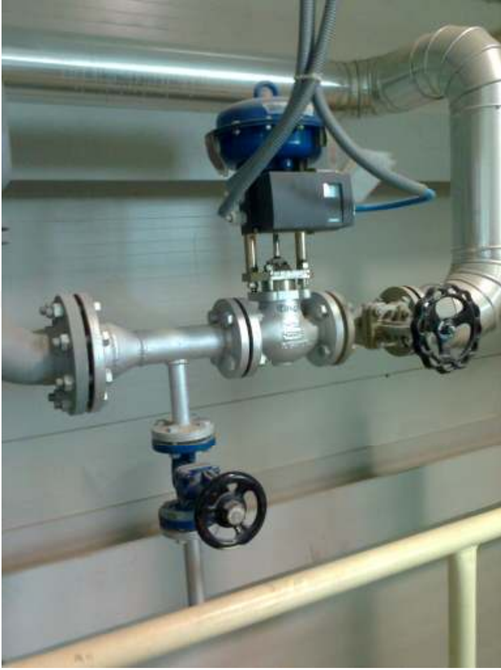
Şekil 4 Ejektör kontrolü
