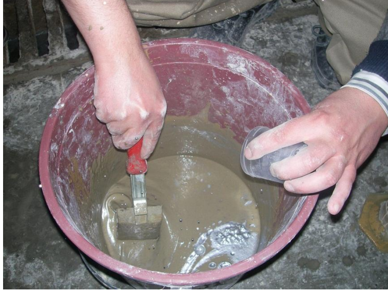
Şekil 3.5. Karışıma alüminyum süspansiyon ilave edilmesi
