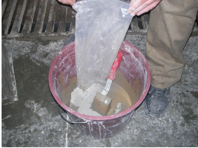
Şekil 3.4. Karışıma çimento-kireç karışımı ilave edilmesi
