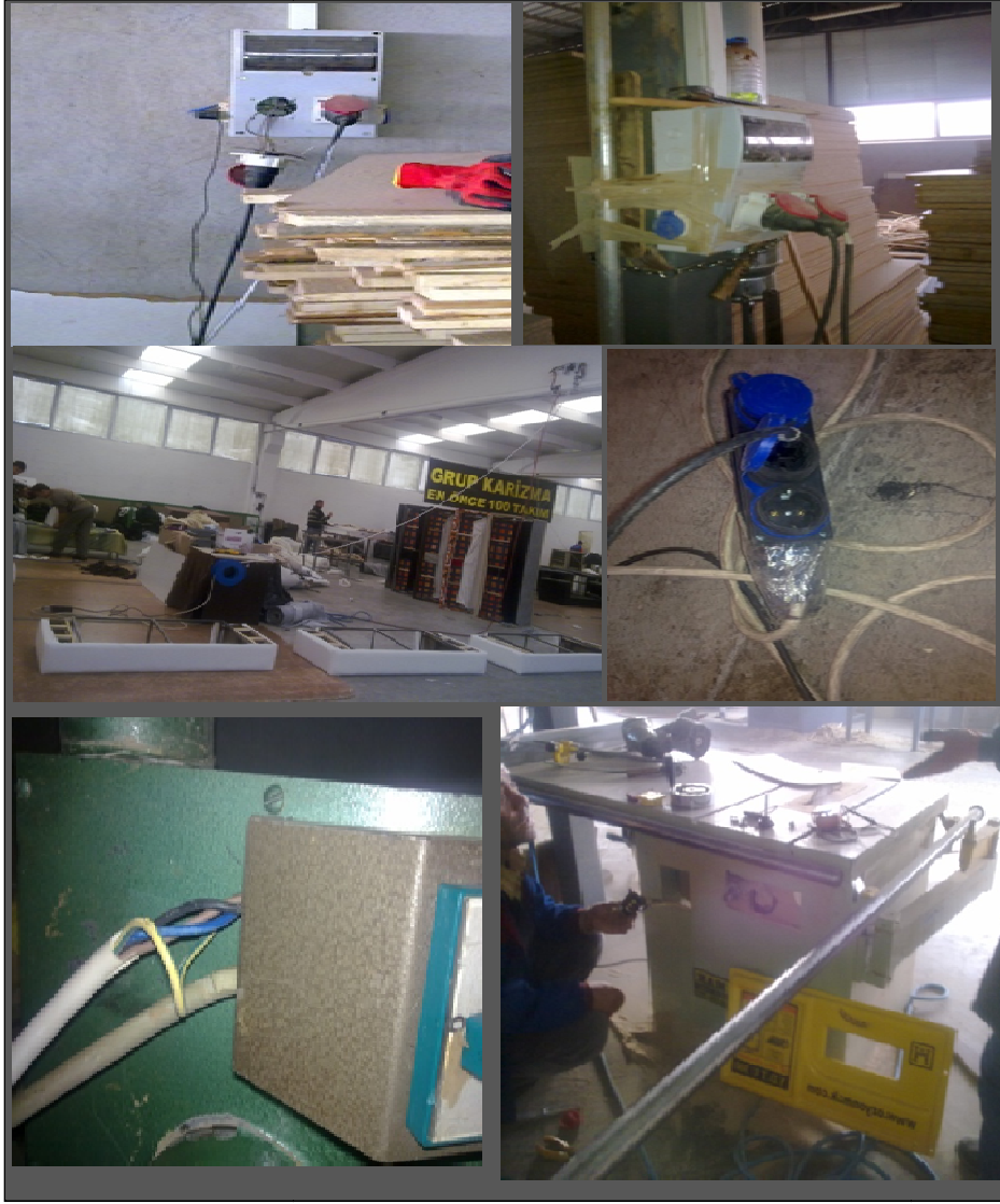
Şekil 5.19. Makinelerin Güvenliksiz Çalıştırılması Ve Tamiri
