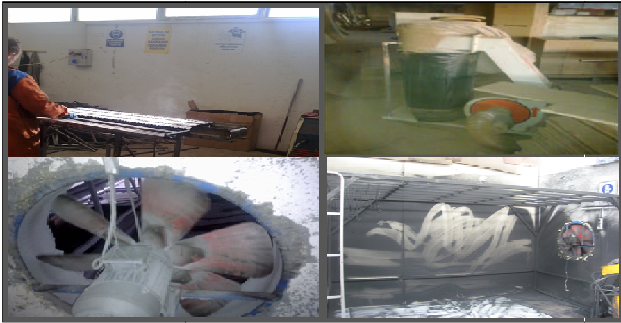
Şekil 5.12. Yetersiz Havalandırma Koşulları
