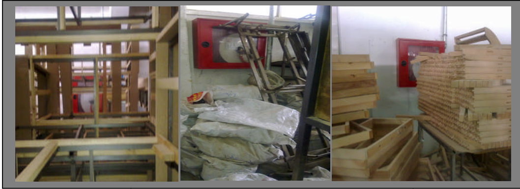
řekil 5.20. Yangın Ekipmanlarındaki Dzensizlikler
