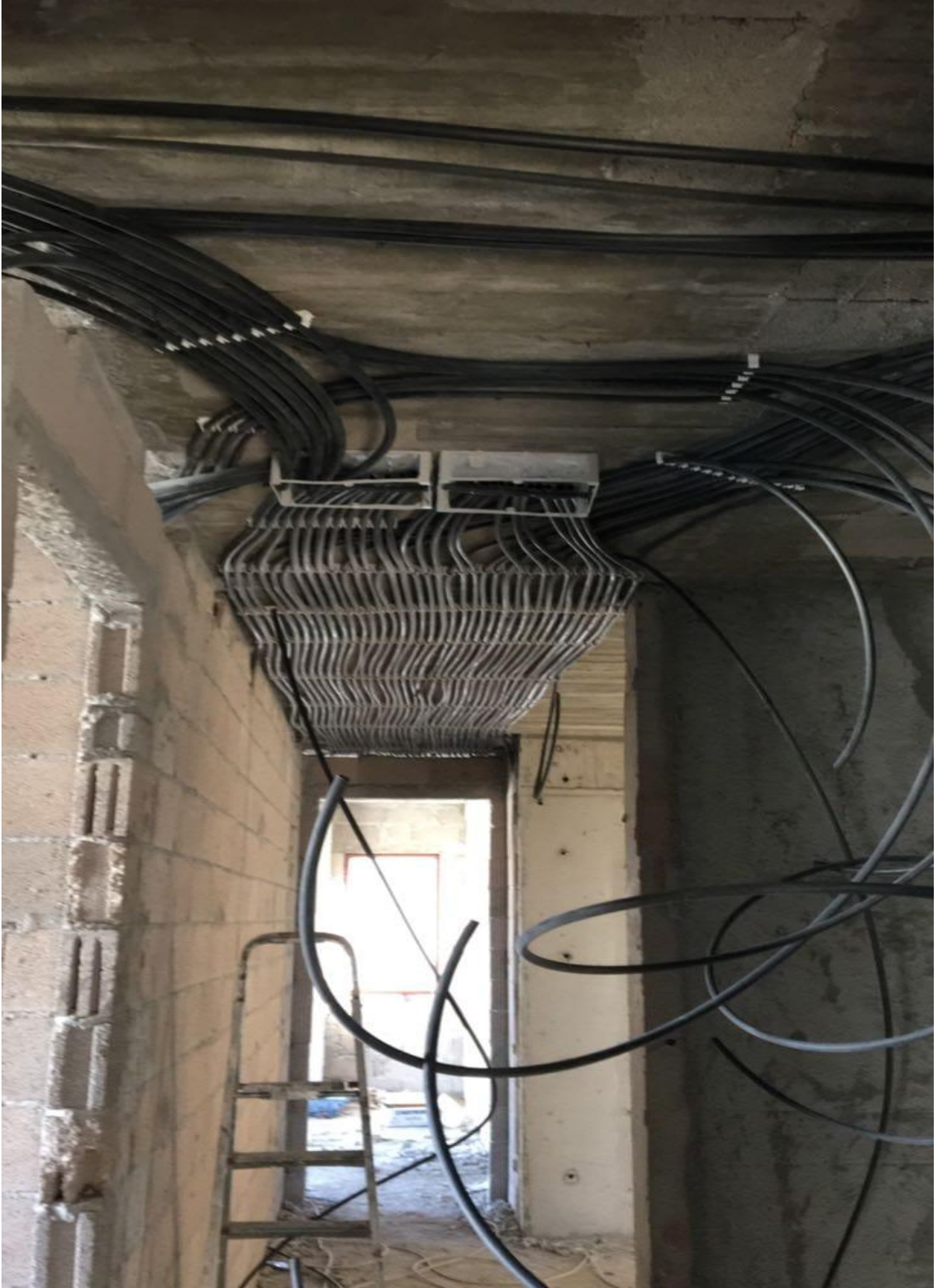
Şekil 6. Akıllı ev sistemi kablolama montajı
