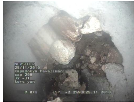
Şekil 2.32. Kanalizasyon hatlarındaki arızalara ilişkin örnekler
