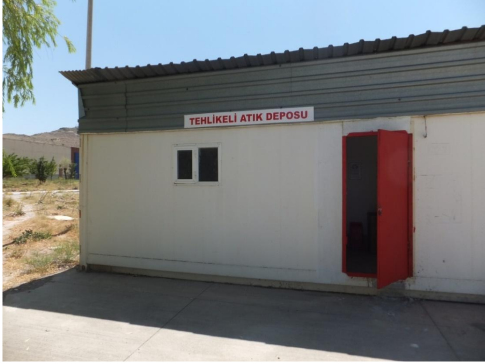
Şekil 2.29. Tehlikeli atık deposu
