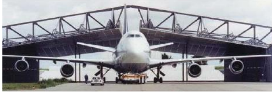
Şekil 2.8. Hamburg-Fuhlsbüttel Havalimanındaki gürültü hangarı
