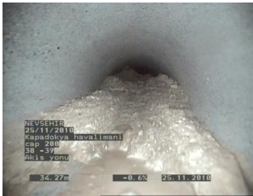
Şekil 2.32. Kanalizasyon hatlarındaki arızalara ilişkin örnekler
