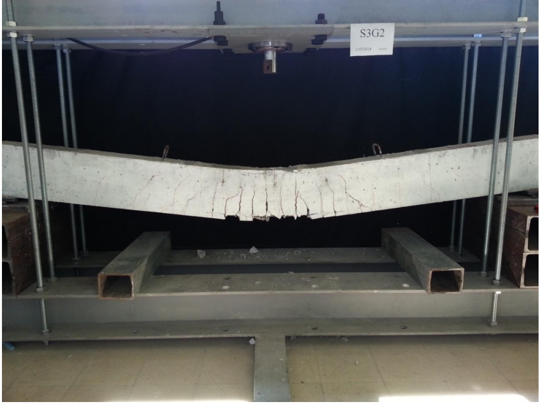
Şekil 2.23. S3G2 elemanın deney sonunda genel hasar durumu
