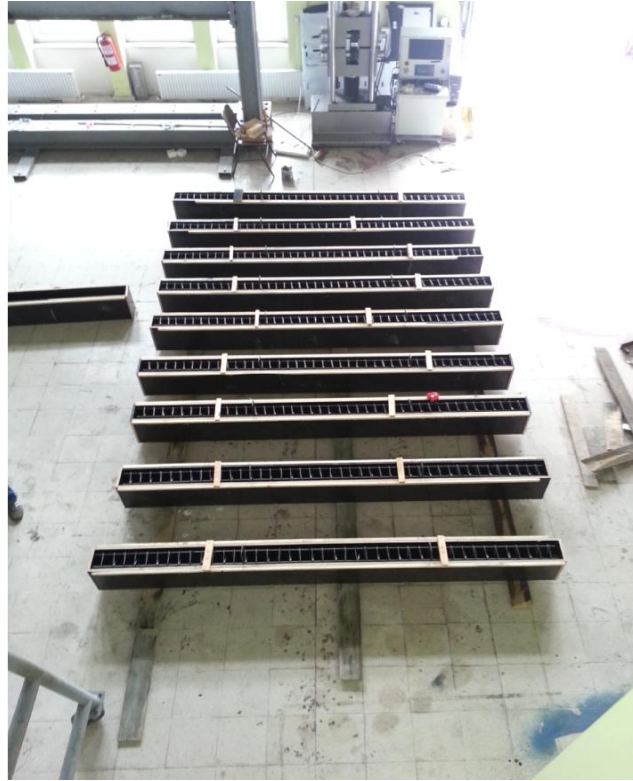
Şekil 2.7. Deney elemanlarının beton dökümü öncesi görünüşü
