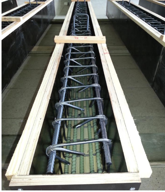
Şekil 2.6. SOG5 (referans) elemanın beton dökümü öncesi görünüşü
