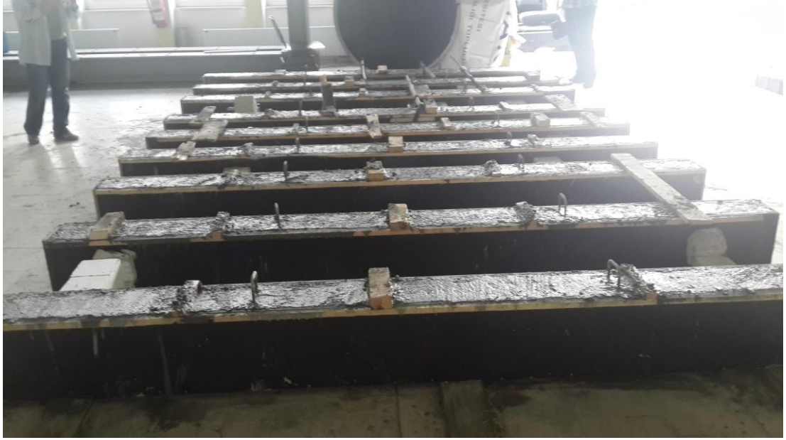
Şekil 2.8. Deney elemanlarının beton dökümü sonrası görünüşü
