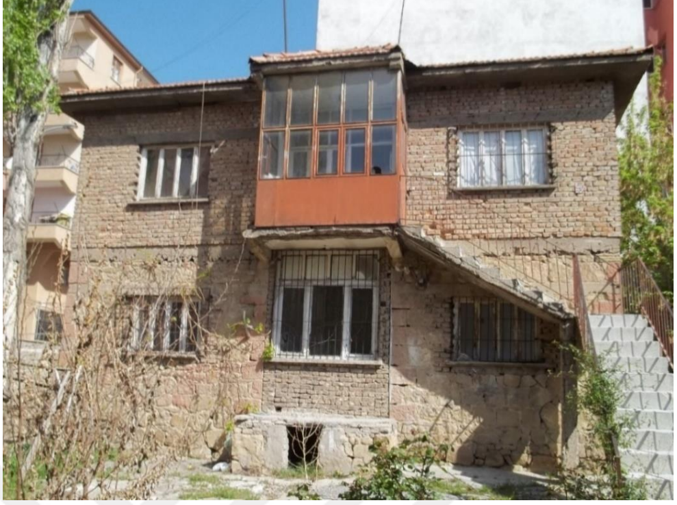
Şekil 3.1. YKN-30319 Yığma Bina Ön Cephe Görüntüsü
