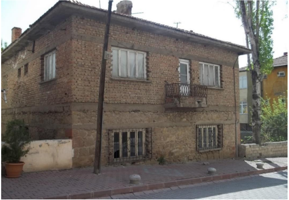
Şekil 3.2. YKN-30319 Yığma Bina Arka Cephe Görüntüsü
