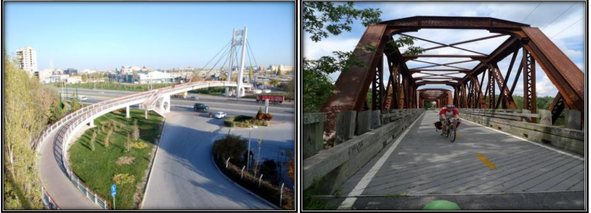
Şekil 2.13.Bisikletlilerin de kullanabileceği geçit ve köprülerde bisiklet yolu tasarım örnekleri. Çevre ve Şehircilik Bakanlığı Bisiklet Kullanım Kılavuzu
