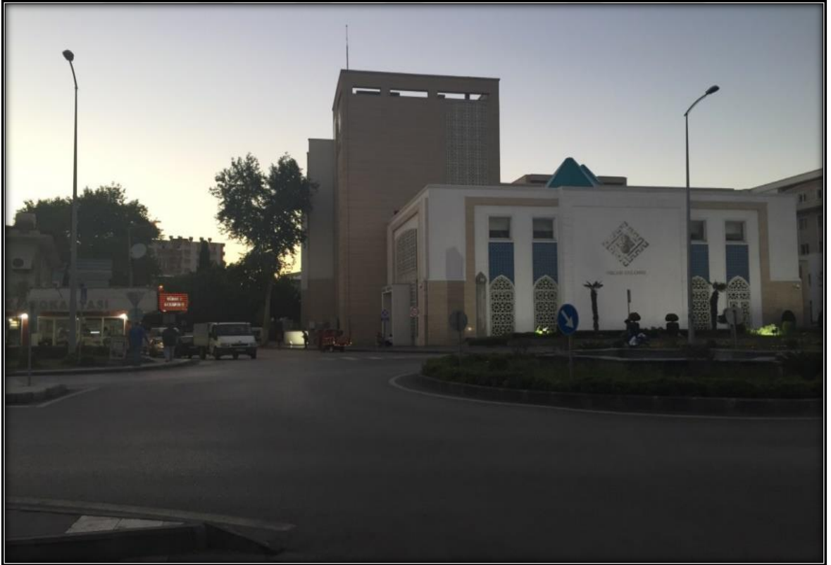
Şekil 4.13. Osmaniye Belediyesi Hizmet Binasından Bir Görünüş (Orijinal 2019)
