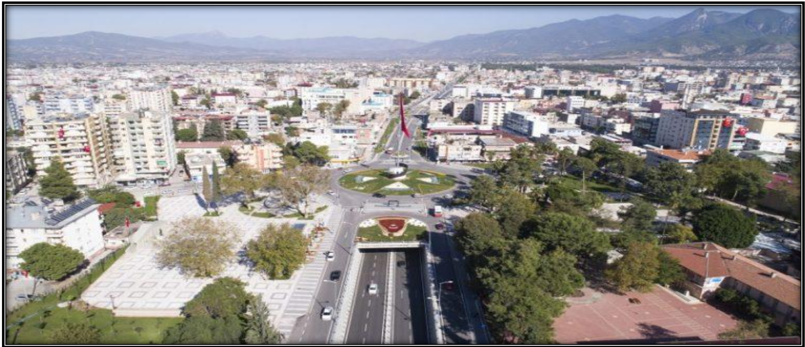
Şekil 4.4. Musa Şahin Bulvarı Üzerinde Bulunan Devlet Bahçeli Altgeçidi ve Meydanının Görünüşü (Anonim-23, 2019)
