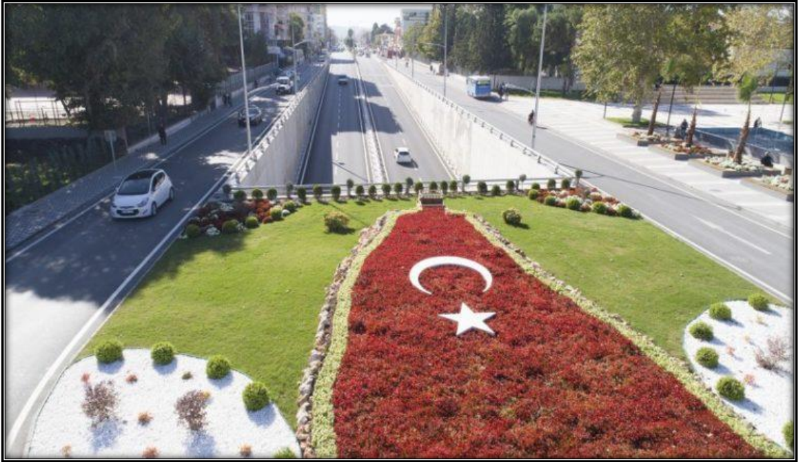
Şekil 5.3.Musa Şahin Bulvarı Üzerinde Yapılan Devlet Bahçeli Alt Geçidinden Bir Görünüş (Anonim-23, 2019)
