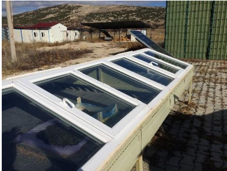
Şekil 3.22. Güneş enerjili kurutma sistemi
