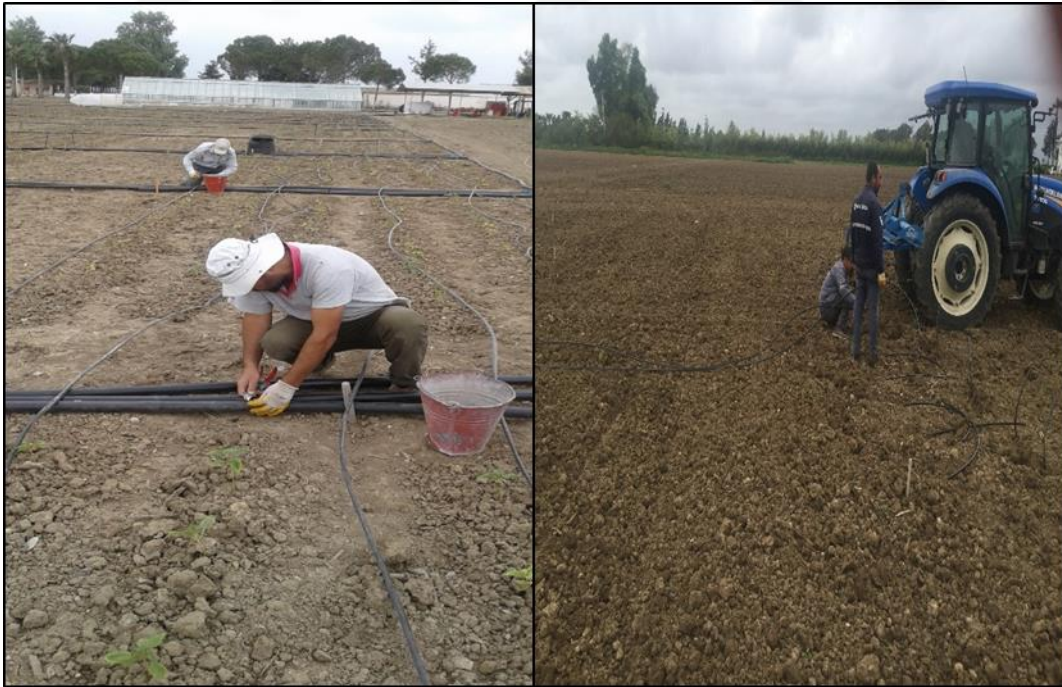
Şekil 3.4. Yüzey ve yüzeyaltı damla sulama sistemlerinin araziye yerleştirilmesi
