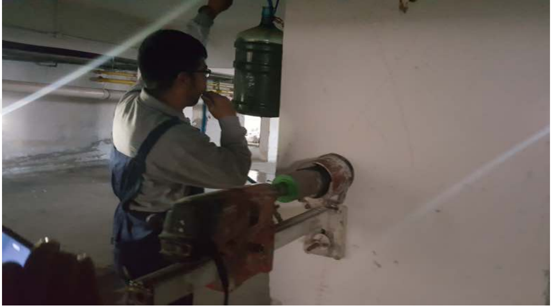
Şekil 6.7. Karot cihazının yerleştirilmesi
