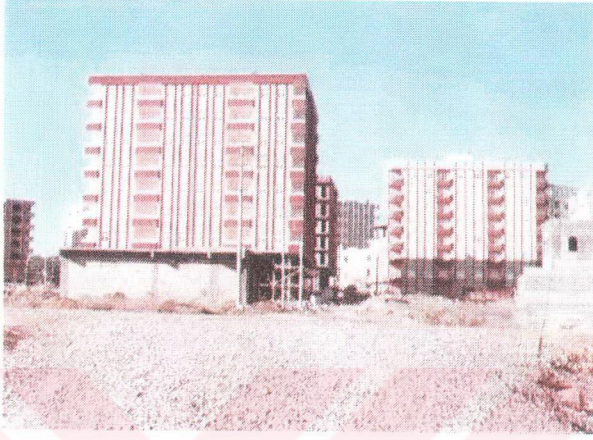
Resim 22 : Yenimahalle : İnşa halinde sokak
