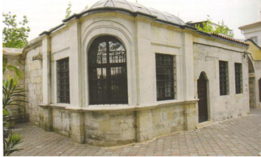
Fotoğraf 26: Selimiye Camii Muvakkithanesi
