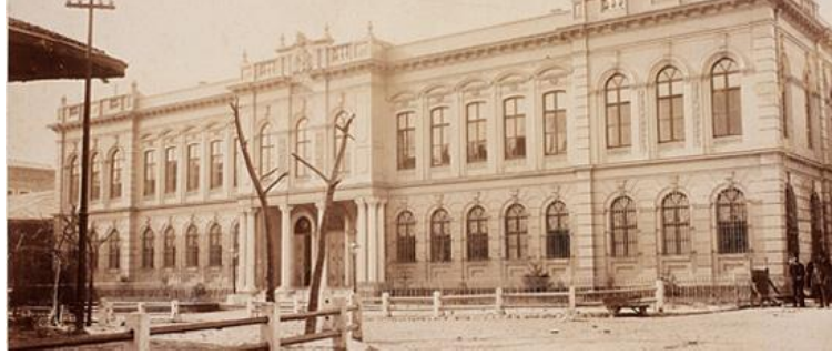
Fotoğraf 58: Eski Postane Binası (1892)
