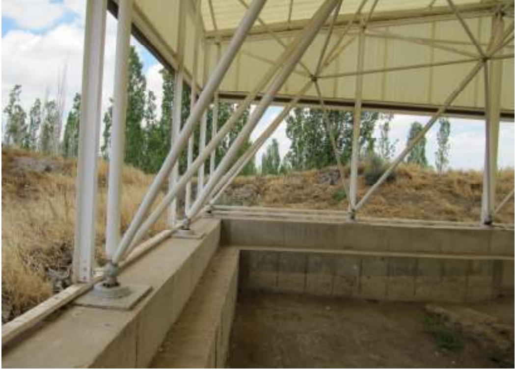
Res. 27c, Çatalhöyük, Güney Alanı Koruma Çatısı Betonarme Temeller (Müge Savrum Arşivi 2010)
