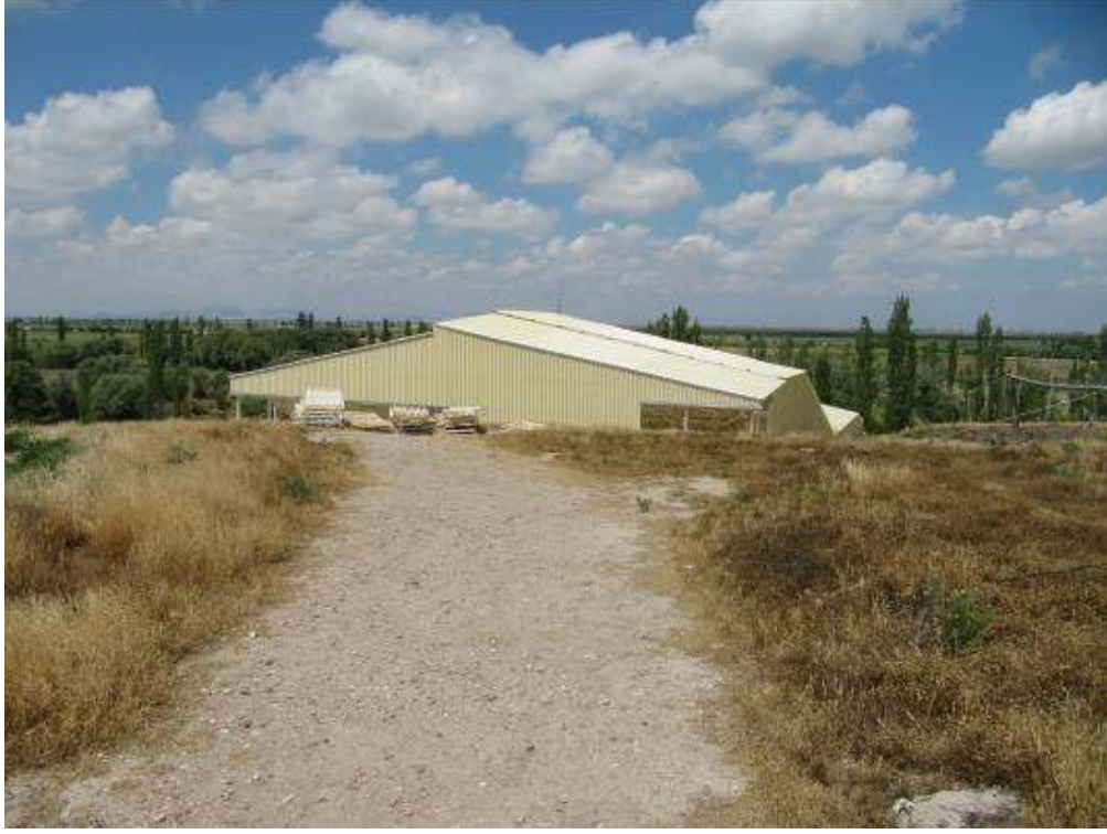
Res. 24a, Çatalhöyük, Güney Alanı Koruma Çatısı (Müge Savrum Arşivi 2010)
