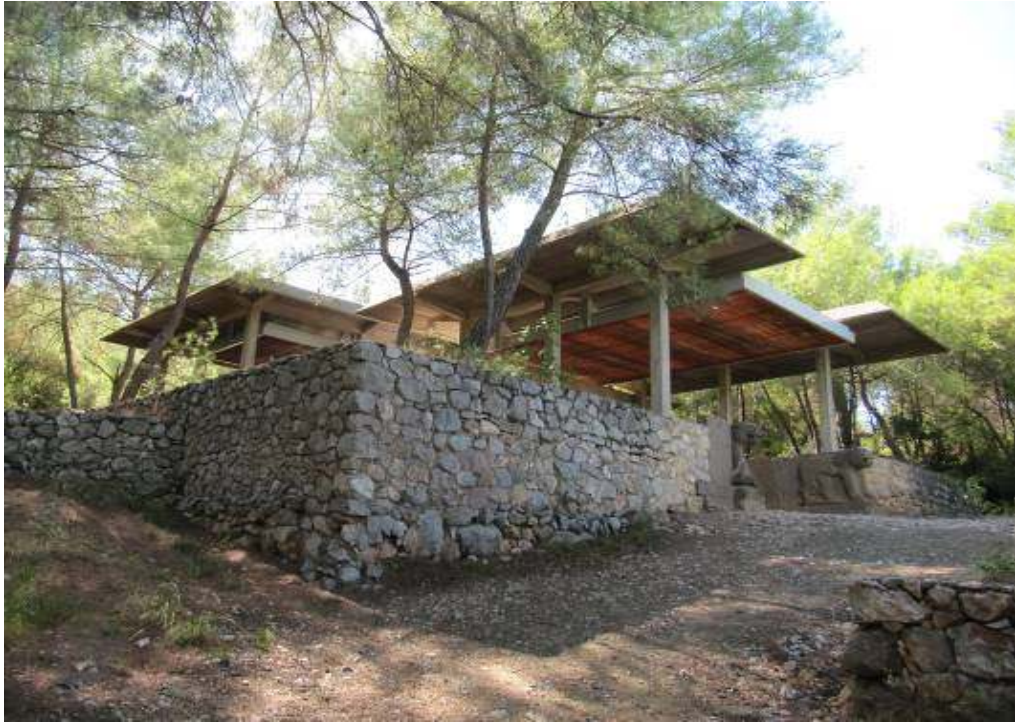
Res. 6b, Karatepe-Aslantaş, Güney Kapı Koruma Çatısı (Müge Savrum Arşivi 2009)
