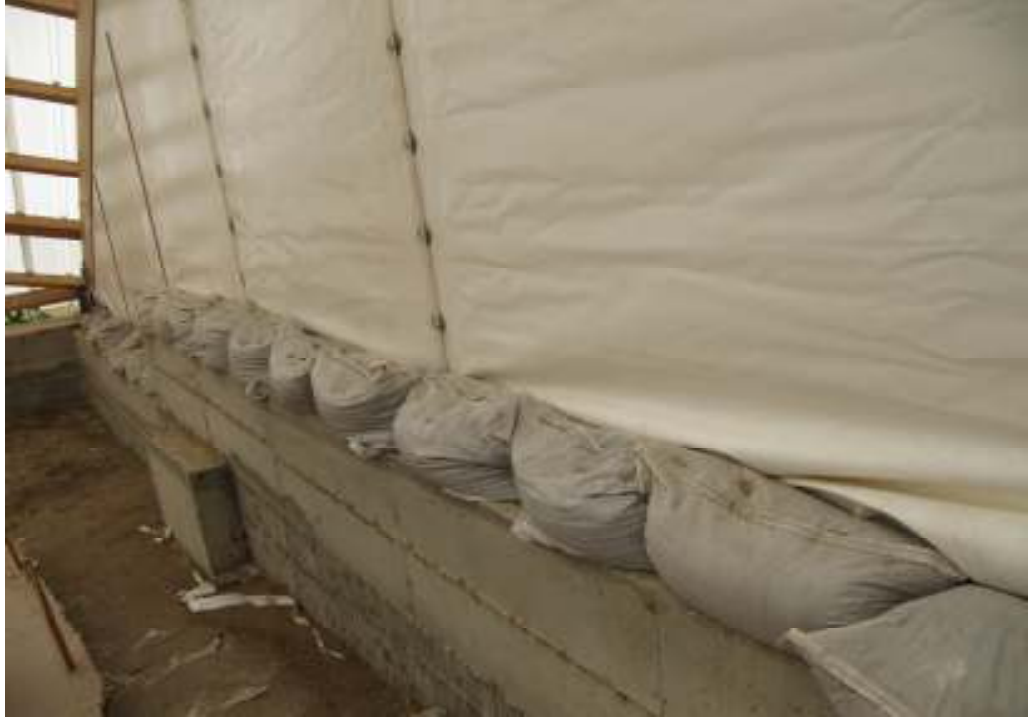
Res. 27a, Çatalhöyük, 4040 Alanı Koruma Çatısı Betonarme Temeller (Müge Savrum Arşivi 2010)
