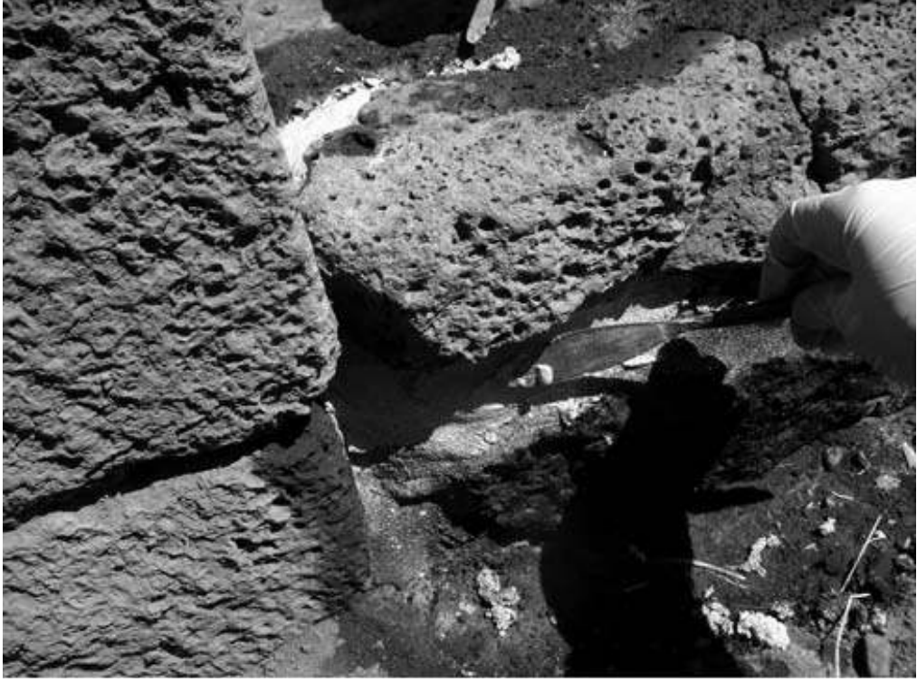
Res. 57, Tilmen Höyük, Taş Duvarlar Arasına Harç İşlemi (Musso, 2008: Fig.9)
