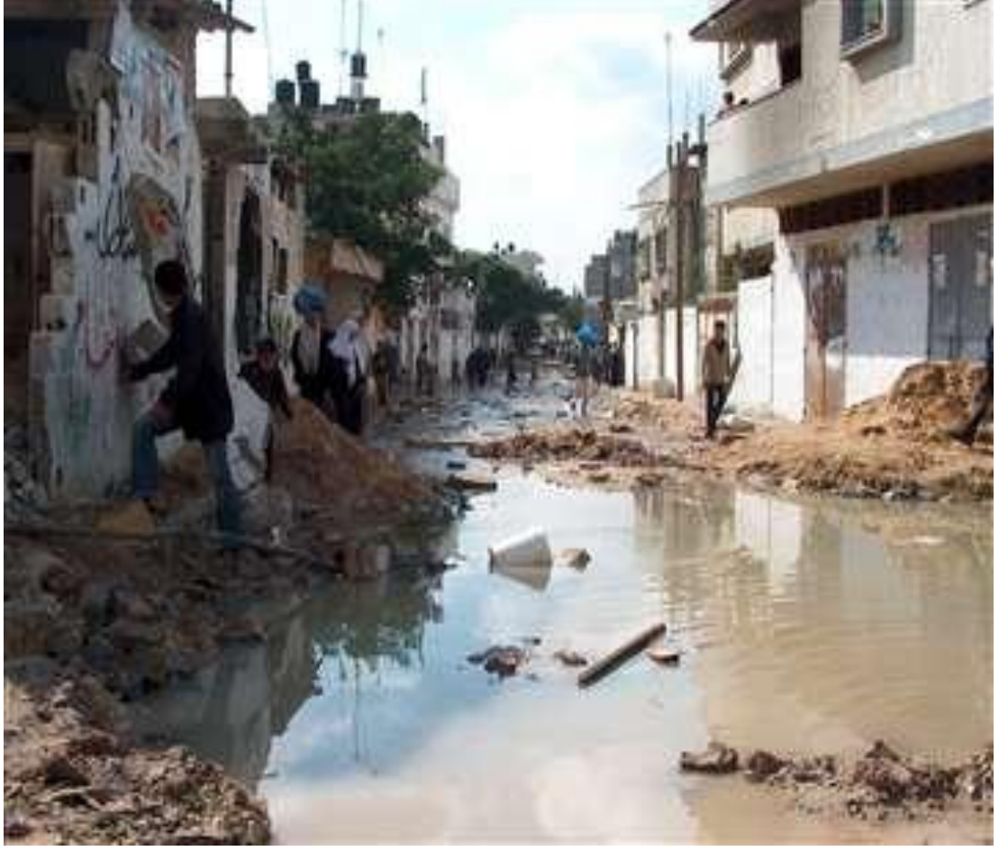
Foto 13: Gazze'de Dökme Kurşun Operasyonu'nda Zarar Gören Su Altyapısı
