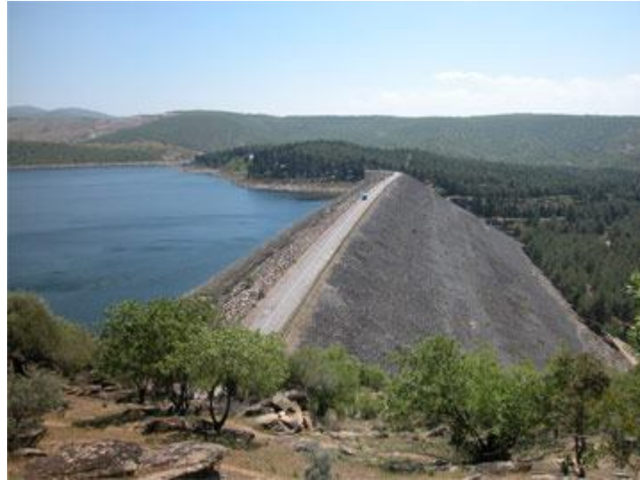
Fotoğraf 37. Toprak Dolgu- Demir Köprü Barajı- Manisa (dsi.gov.tr)
