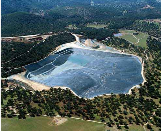
Fotoğraf 186. Jeomembranın su depolama amaçlı uygulanması (sol), (troser.com)
