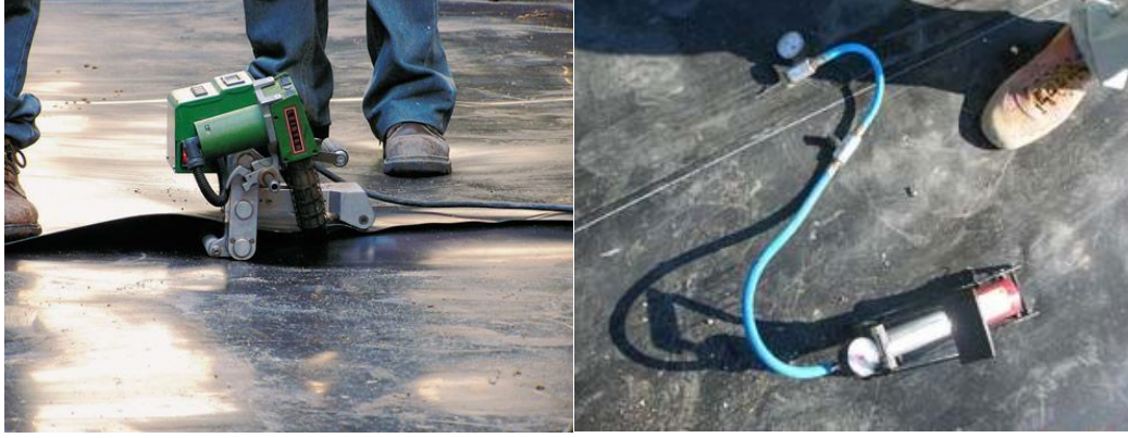
Fotoğraf 184. Jeomembranların Ekstürüzyon kaynağı ile birleştirilmesi (sol) ( tokgozmakina.com.tr/uygulama-liste.asp?Id=235 )
