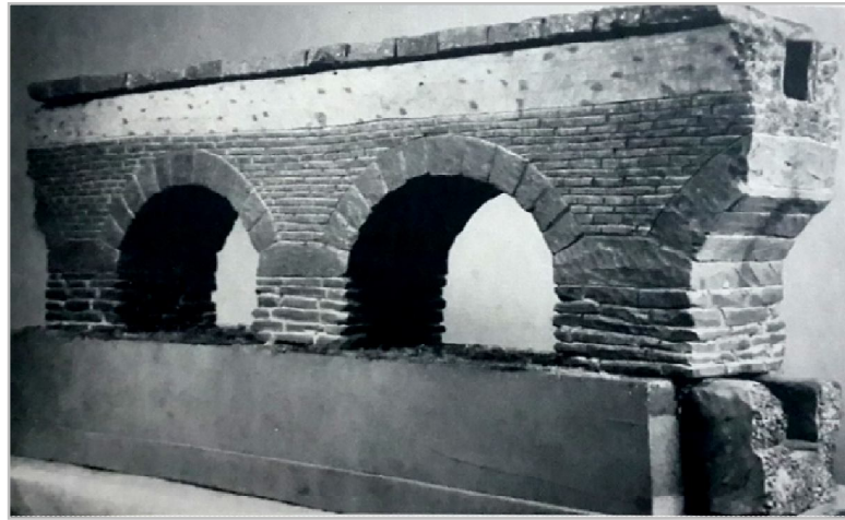
Fotoğraf 4. Üstü kapatılmış su kemeri- (Eifel su şebekesi modeli) (Kretzschmer, 2010: 91)
