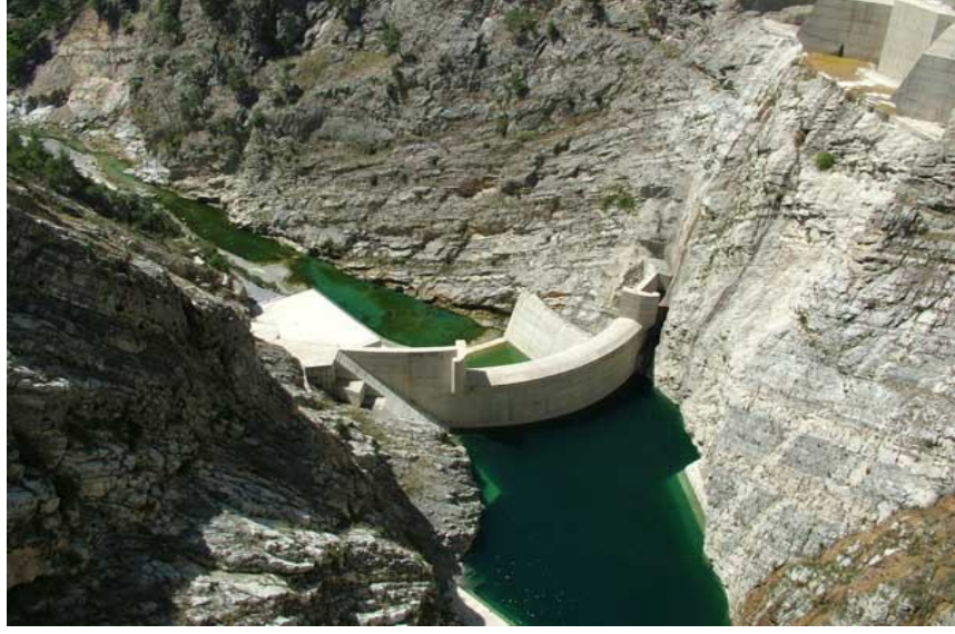
Fotoğraf 34. Berke Barajı- Kemer baraj (dsi.gov.tr)
