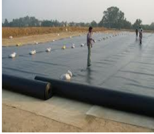
Fotoğraf 183. Jeomembran uygulamasına örnek ( geosentetikler.net/arsatirmalar/geomembran-seciminde-yeni-matris.html )
