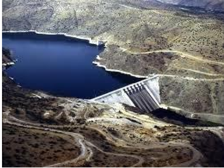
Fotoğraf 132. Sarıyar Barajı ( msxlabs.org/forum/turkiye-cografyasi/299292-turkiyenin-barajlari-sariyar-baraji-ve-hidroelektrik-santrali.html )
