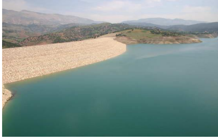
Fotoğraf 36. Toprak Dolgu- Ayvalı Barajı– Kahramanmaraş (sehirler.net/resim-kahramanmaras-resimleri-38-ayvali-baraji-3639.htm)
