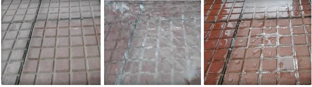
Fotoğraf 208. Tuğla yüzey uygulaması (sol) ( innovcoat.com.tr/index.html )
