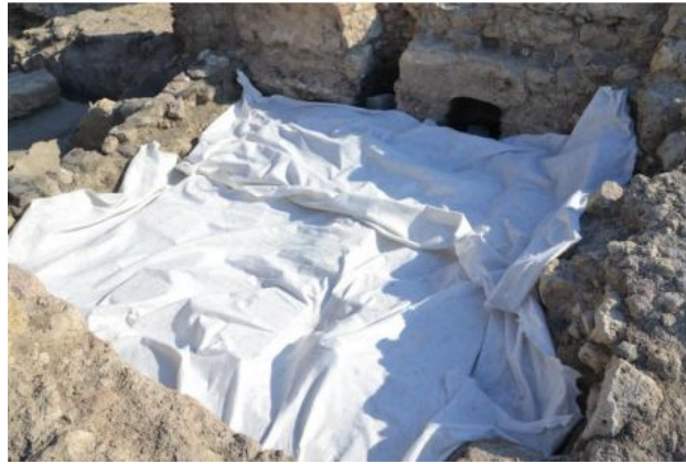
Fotoğraf 179. Cevher paşa hamamının jeotekstil ile örtülen bölümlerden biri (Ersoy, 2012: 10)
