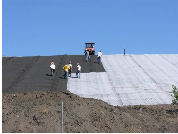
Fotoğraf 191. Jeosentetik kil astarın uygulama örneği ( geosentetikler.net/geosentetik-kil-ortu )
