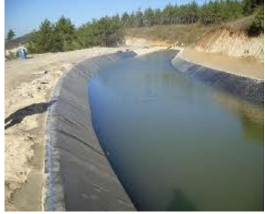
Fotoğraf 186. Jeomembranın su depolama amaçlı uygulanması (sol), (troser.com)
