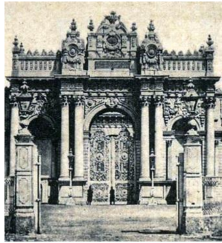
Resim 114: Dolmabahçe Sarayı Saltanat Kapısı (Detay).
