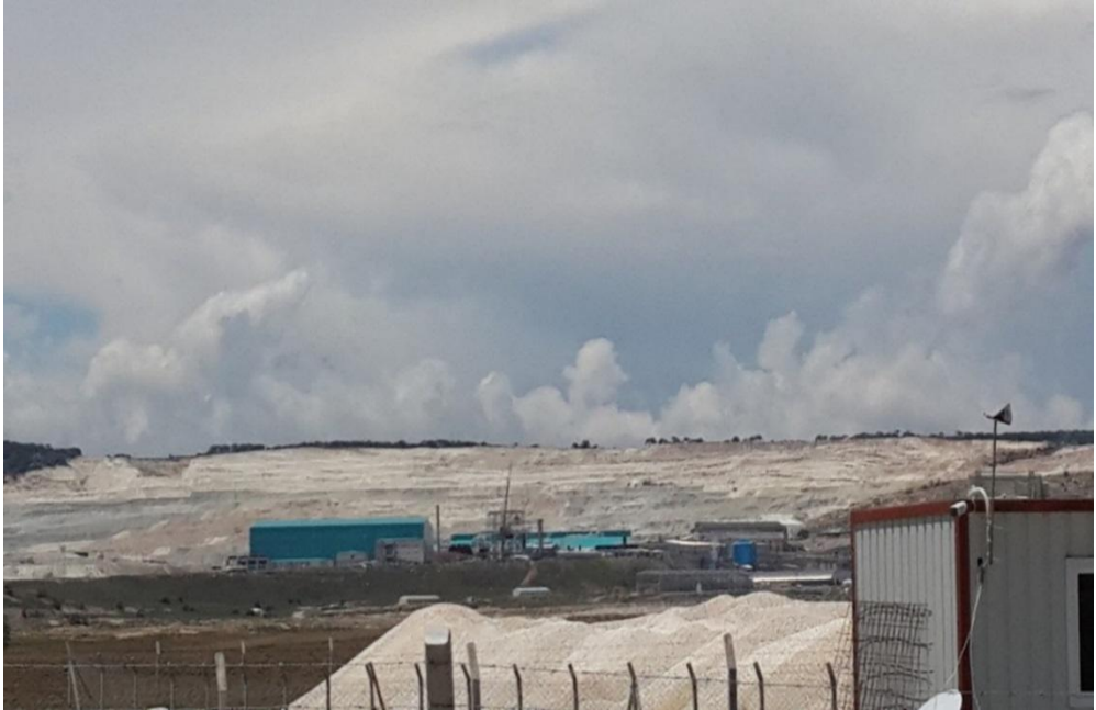
Foto 43: Kırka ETİ Bor İşletme Tesisleri.
