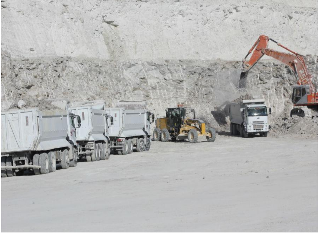
Foto 44: Kırka Eti Bor İşletme Tesisleri.
