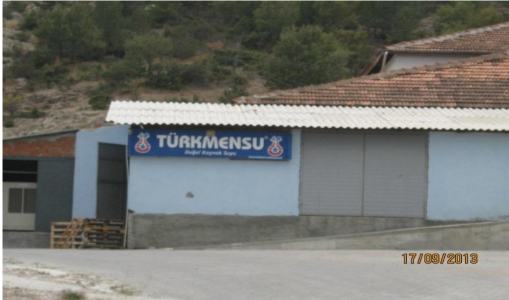
Foto 55: Türkmen Dağı, Türkmensu Doğal Kaynak Suyu Tesisleri.
