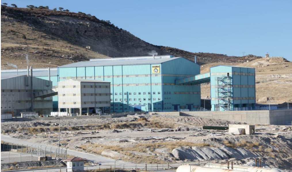
Foto 45: Kırka Eti Bor İşletme Tesisleri.
