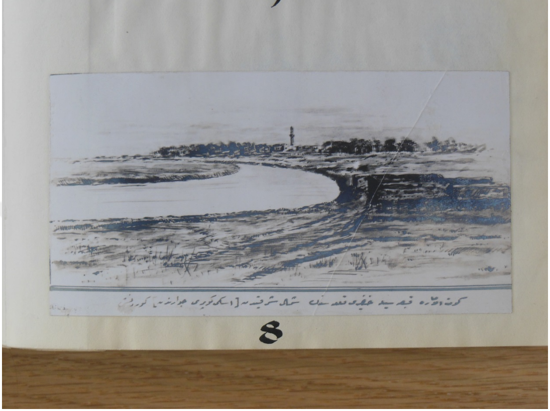
Kutü'l Amare kasabasıyla Hafiri Kalesi'nin şimal-i şarkiden( eski köprü civarından) görünüşü, (Ref: CAB 44/34)
