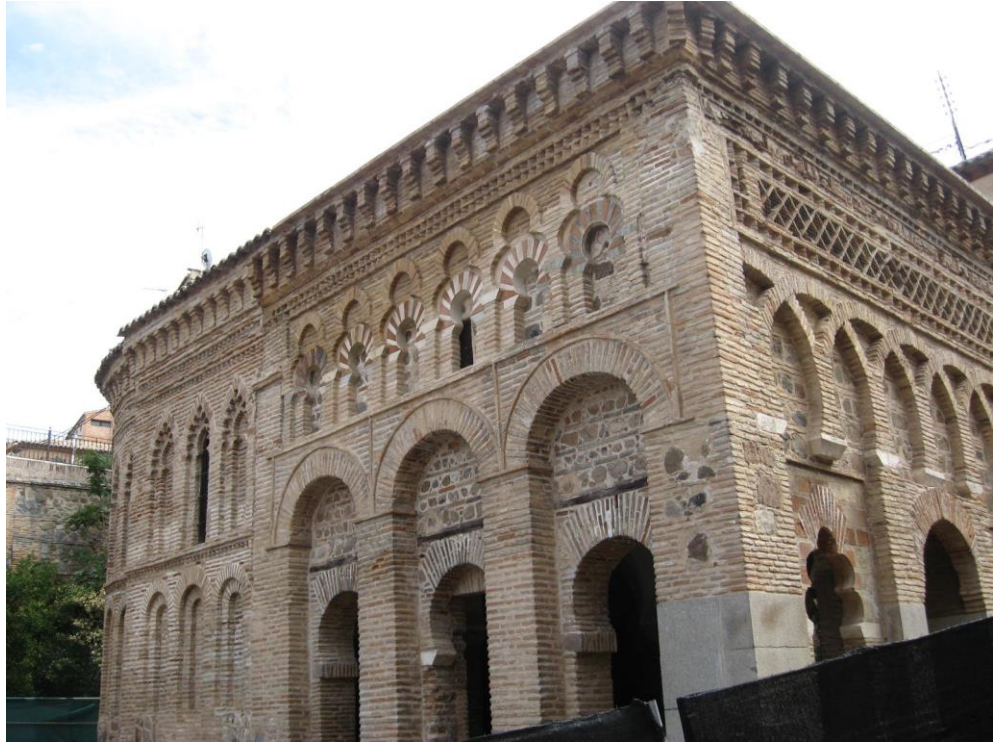
EK7: Tuleytula'da V/XI. yüzyıl başlarında inşa edilen Bâb Merdum Camii.
