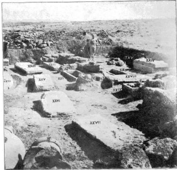
Fig. 4. — Vue du chantier, prise de l'angle S.O.
