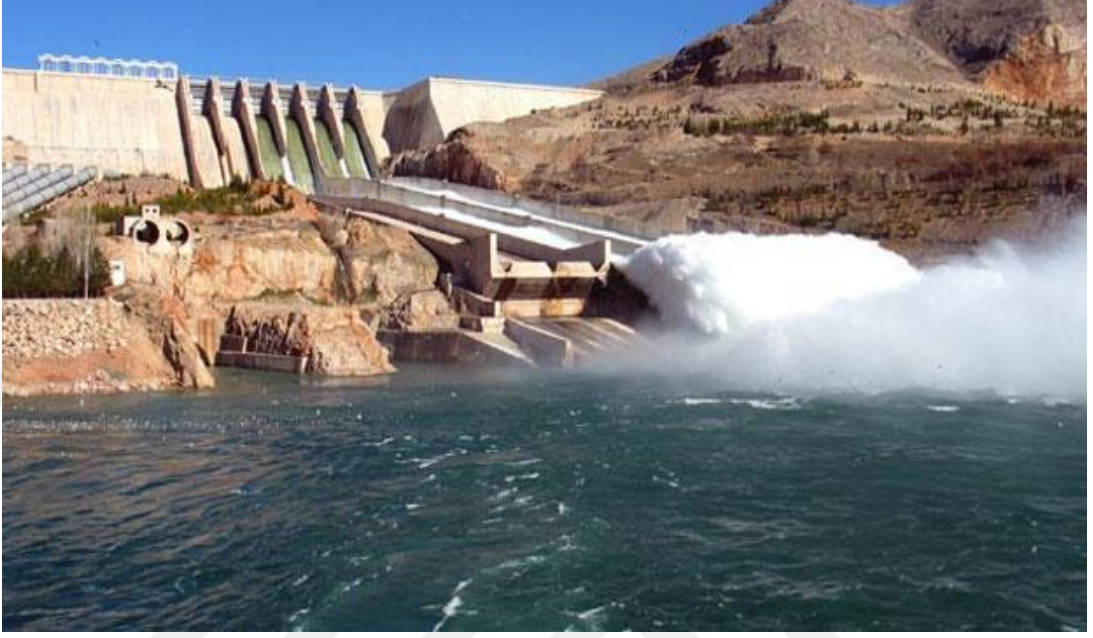
Şekil 2.10: Keban Barajı ve hidroelektrik santrali (HES).
