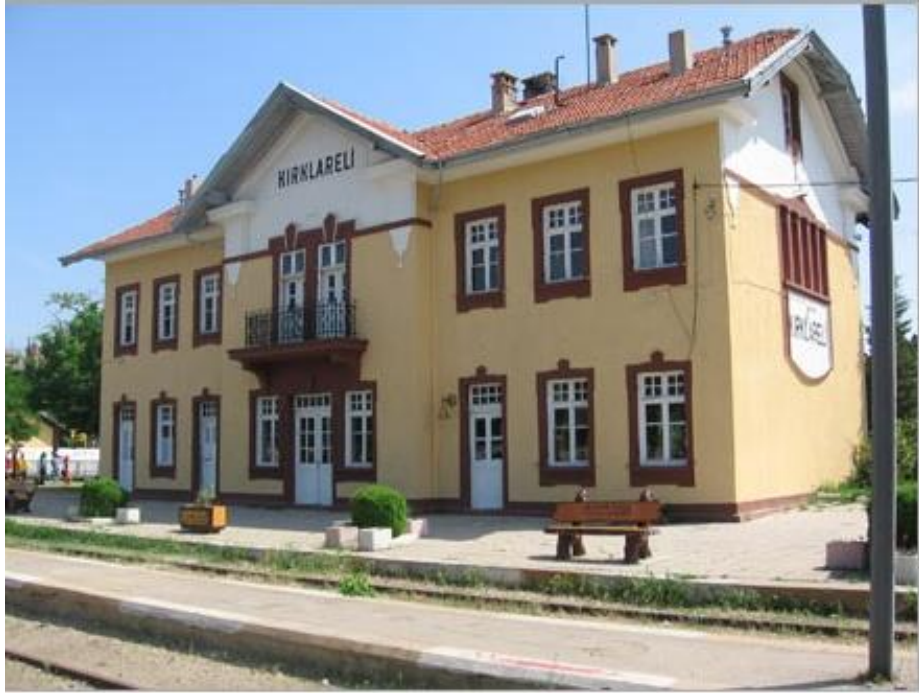
Şekil 3.1 : Kırklareli Eski Tren Garı Binası (Url-1).
