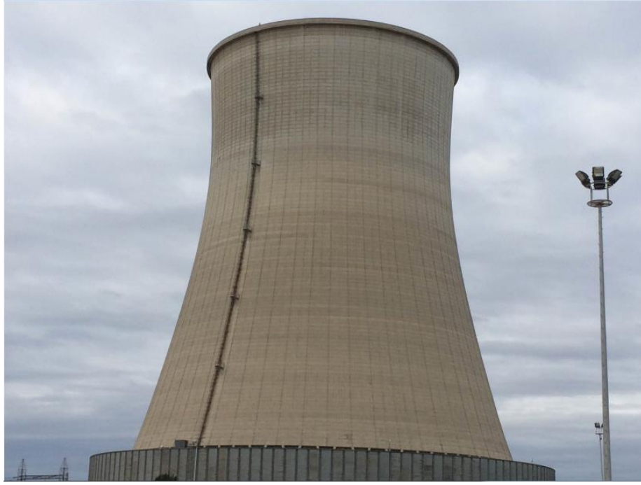
Şekil 3.4 : Kırklareli'nde Hamitabat Doğalgaz Çevrim Santralinde 135 m yüksekliğindeki Soğutma Bacası.
