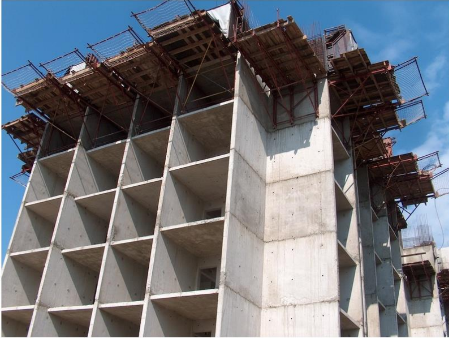
Şekil 3.3 : Tünel kalıp sistemi ile inşa edilen konut inşaatı (Url-2).
