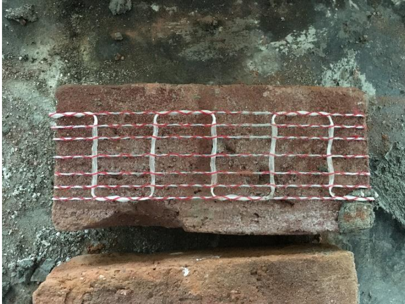
Resim 3.16. Yatay derz donatısının yerleştirilmesi
