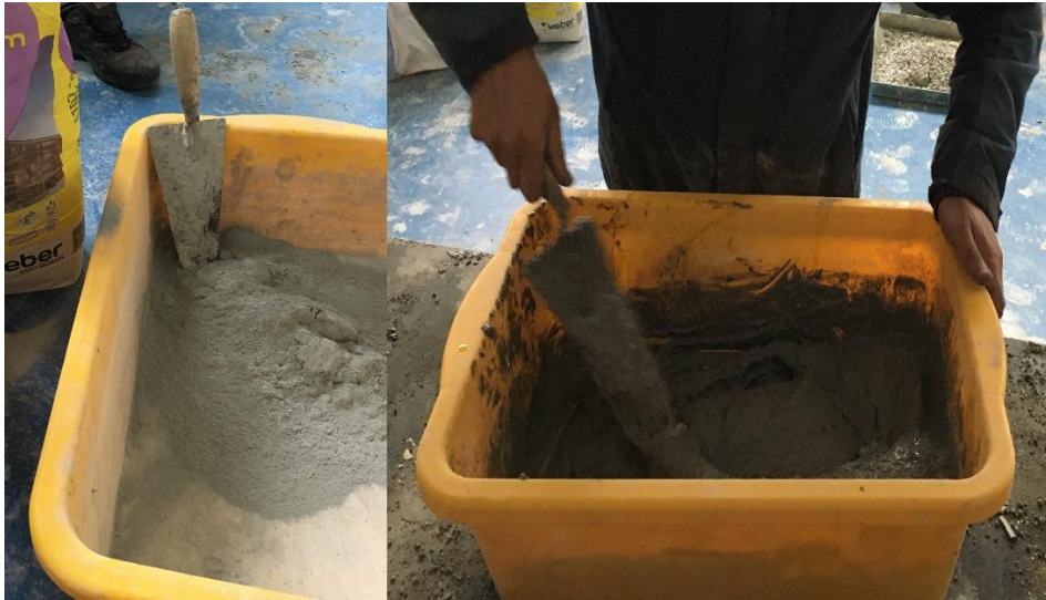
Resim 3.5. Harcın hazırlanması
