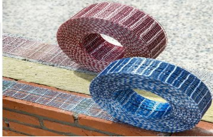
Şekil 2.7. Şerit tip yatay derz donatısı
