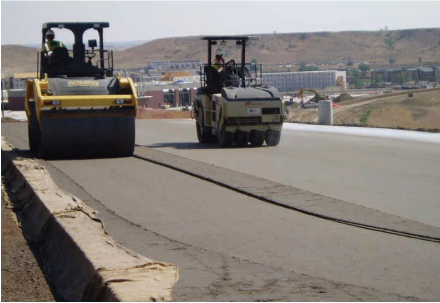
Şekil 4.3: SSB silindirle sıkıştırılması (Andriolo R.F, 1998).
