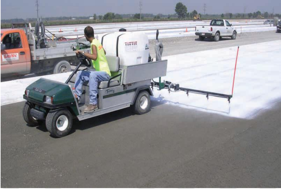
Şekil 4.4: Kür malzemesinin uygulanması(TÇMB, 2017).
