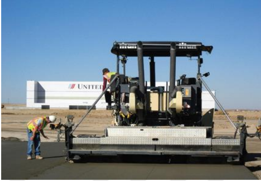
Şekil 4.2: SSB yol serim uygulaması(Andriolo R.F, 1998).
