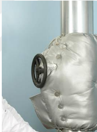
Şekil 2.19 : Vanalara ceket uygulaması.
