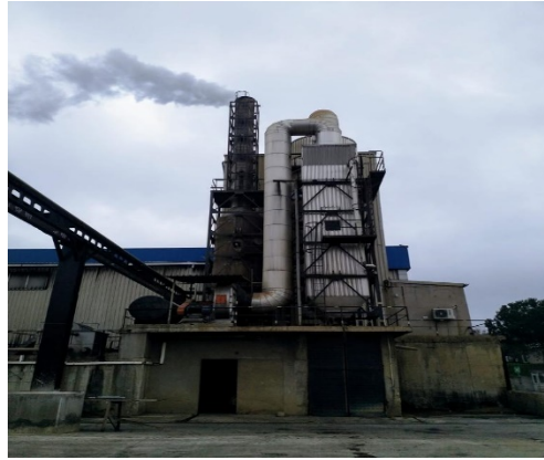
Şekil 2.15 : Akışkan yataklı kömür kazanı.
