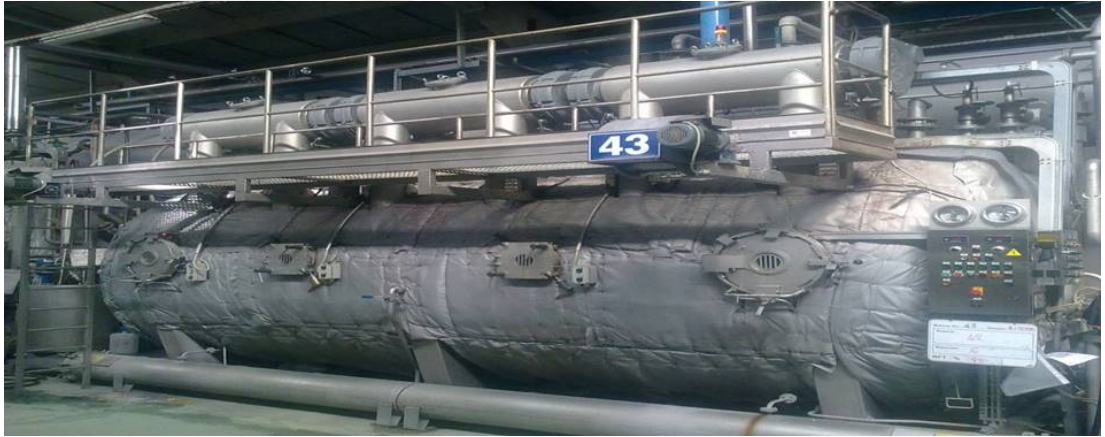
Şekil 2.18 : Boyama makinelerine izolasyon uygulaması.
