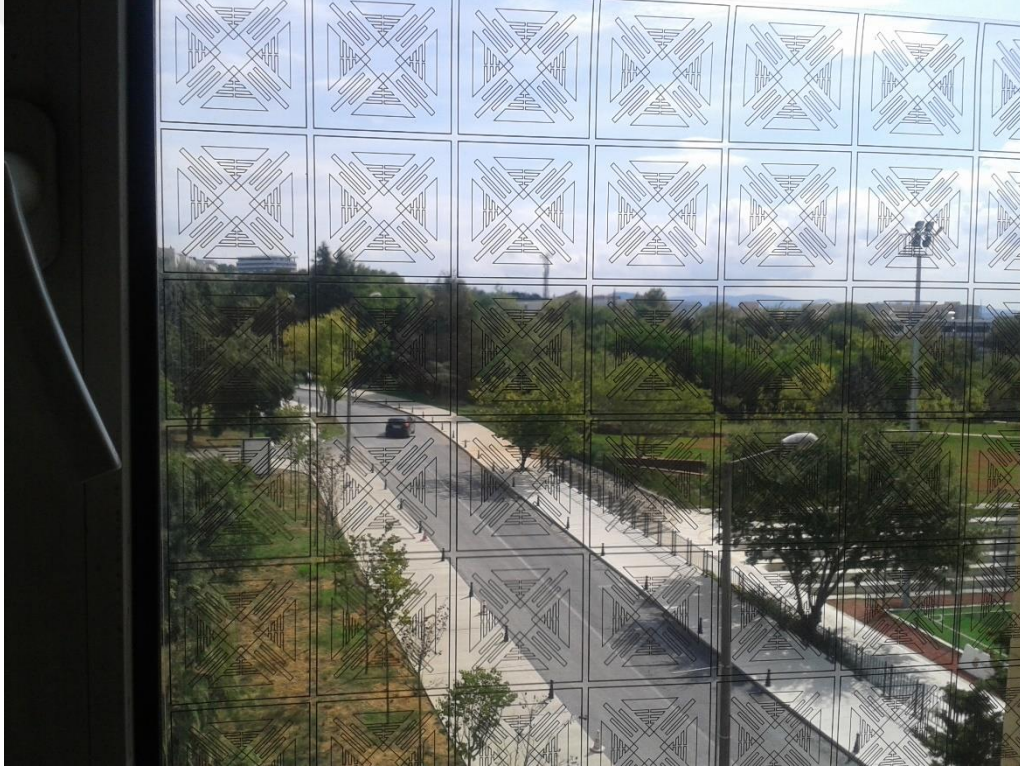
Şekil 3.20 : Şeffaf olarak cama uygulanmış FSY örneği.
