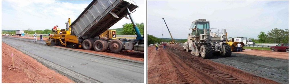
Şekil 2.4 : Uçucu külün zemine uygulanması
