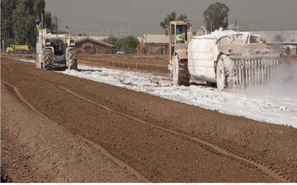
Şekil 2.1 : Kirecin yol yapımında uygulanması
