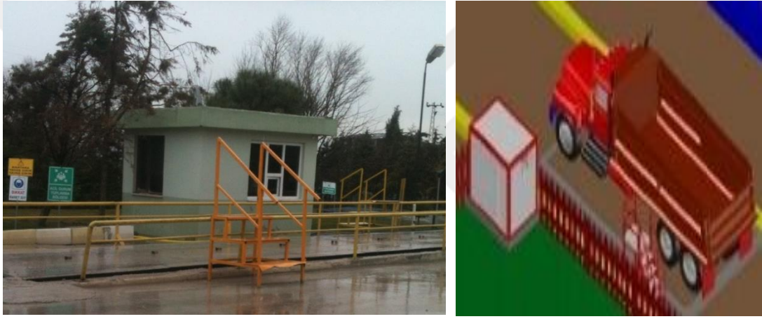
Şekil 5.17 : Agregta kamyonundan numune alma için kullanılacak platform.
