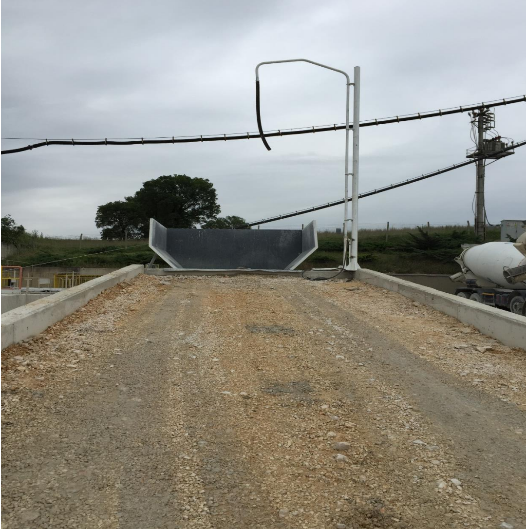
Şekil 4.17 : Transmikserlerin dolum sonrası beton artıklarının temizlendiđi alan.
