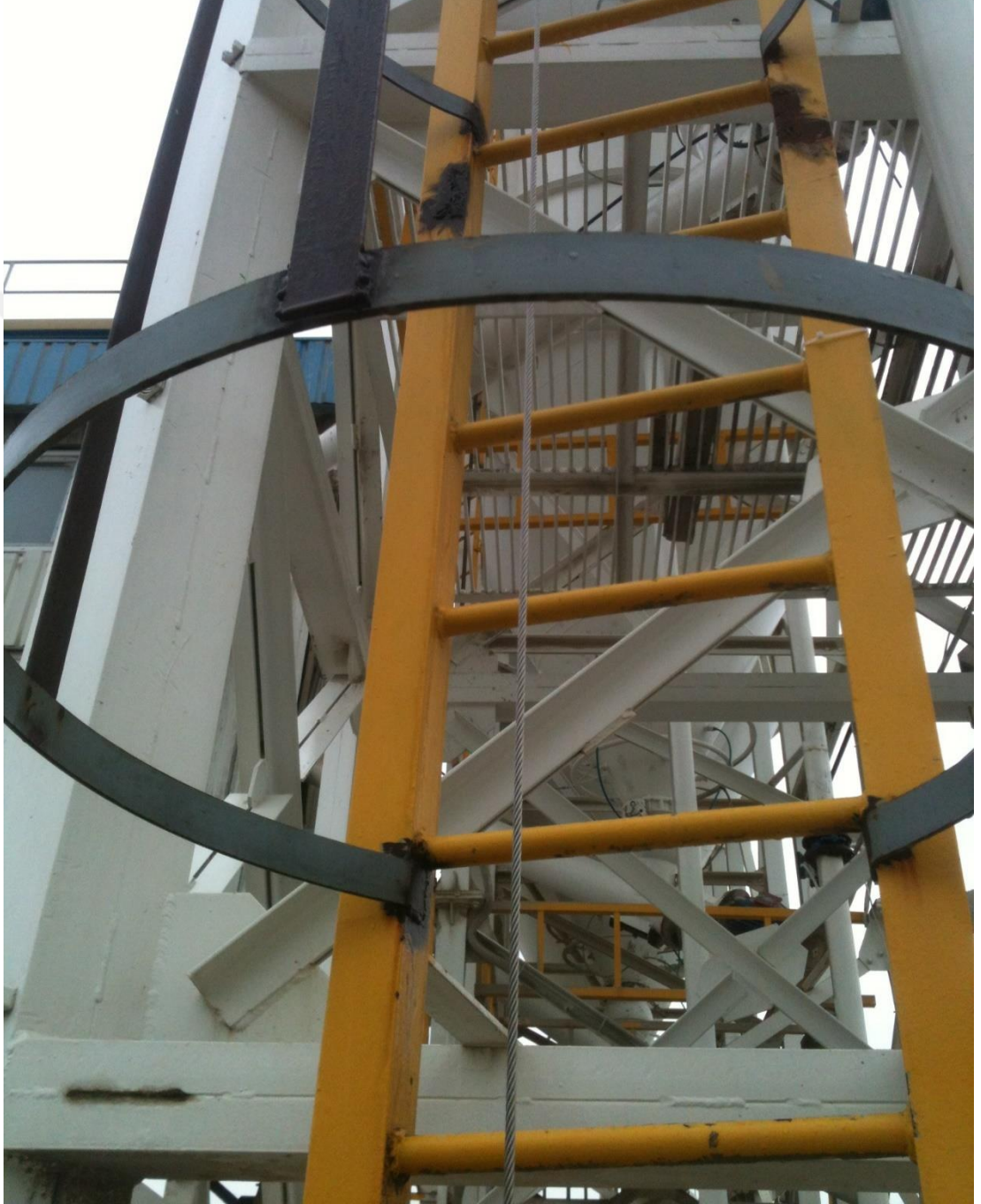
Şekil 5.15 : Gemici merdivenine çıkışta çalışanın paraşüt tipi emniyet kemerinin bağlantısı yapacağı dikey yaşam hattı.
