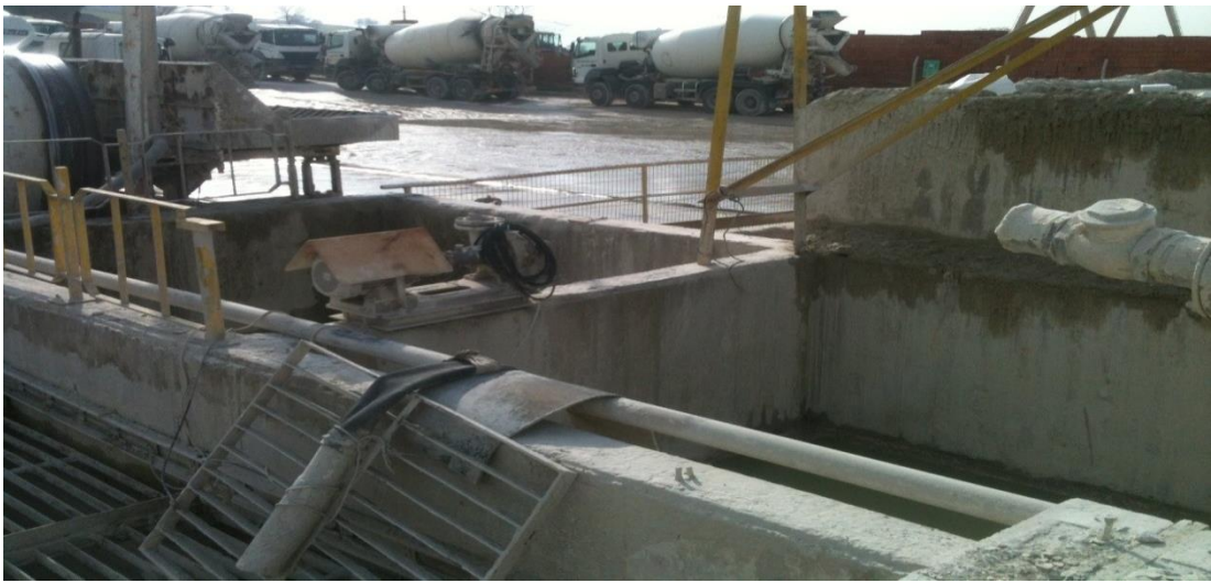
Şekil 4.14 : Kenar korkulukları bulunmayan ve üstü kapatılmamış havuzlar.
