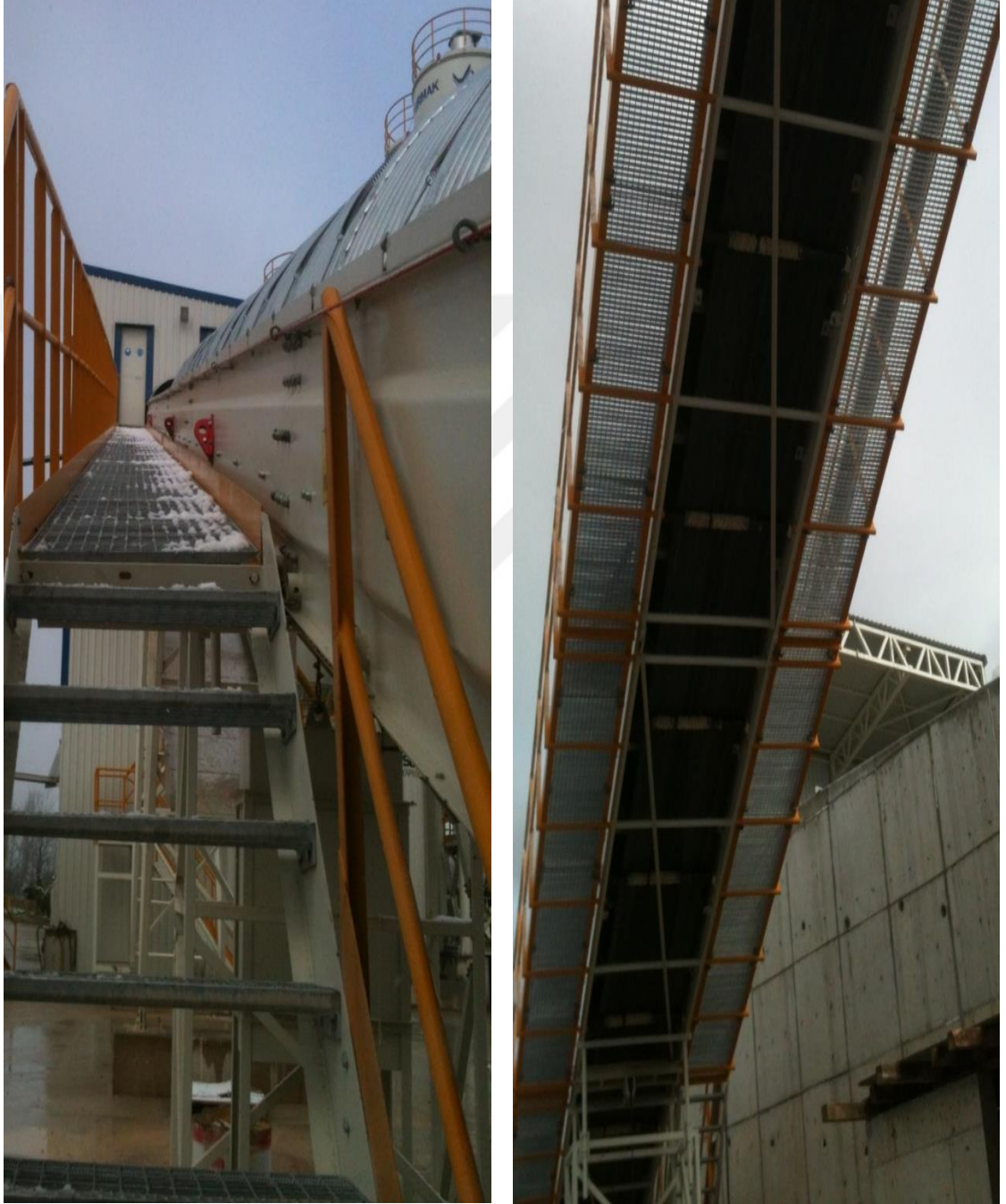
Şekil 5.8 : Agrega taşıma bantı yanında bulunan agrega birikmesine ve çalışanın kayma riskine karşı ızgara platform zemini.
