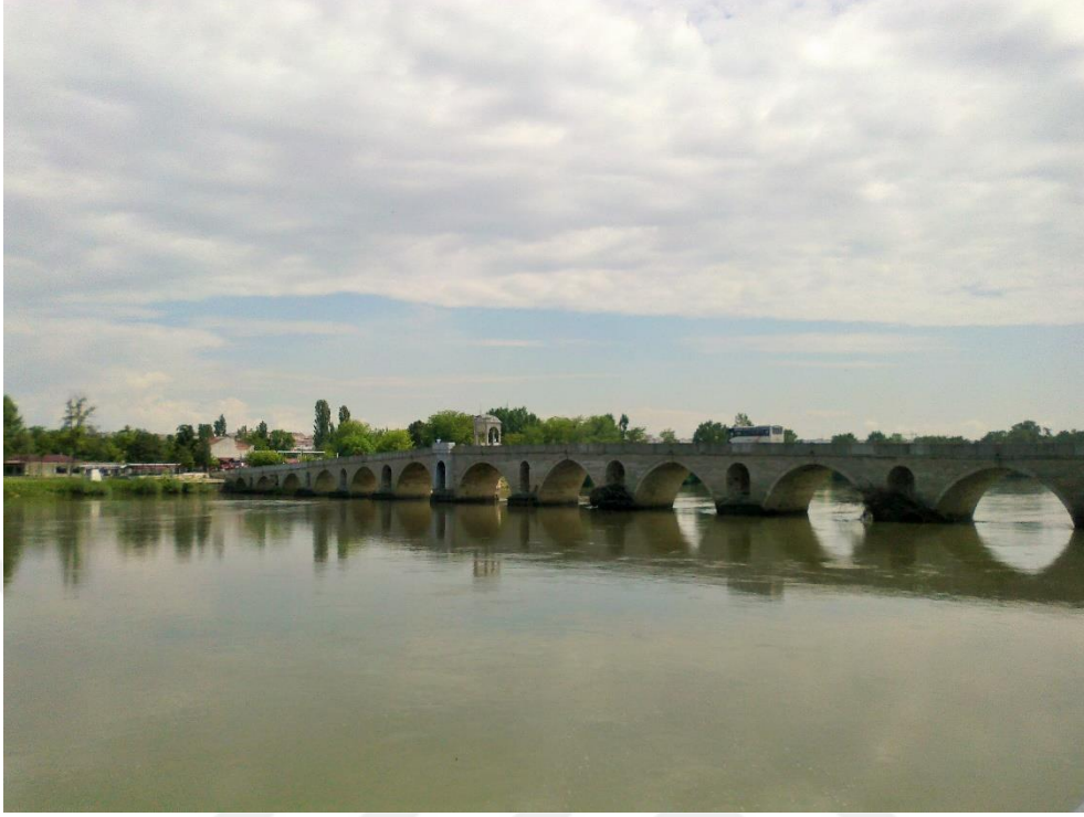
EK 17: Meriç Köprüsü (Yeni Köprü) 507
