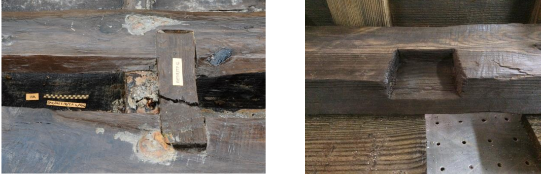
Şekil 67: İskaça desteği üzerindeki girintiler
