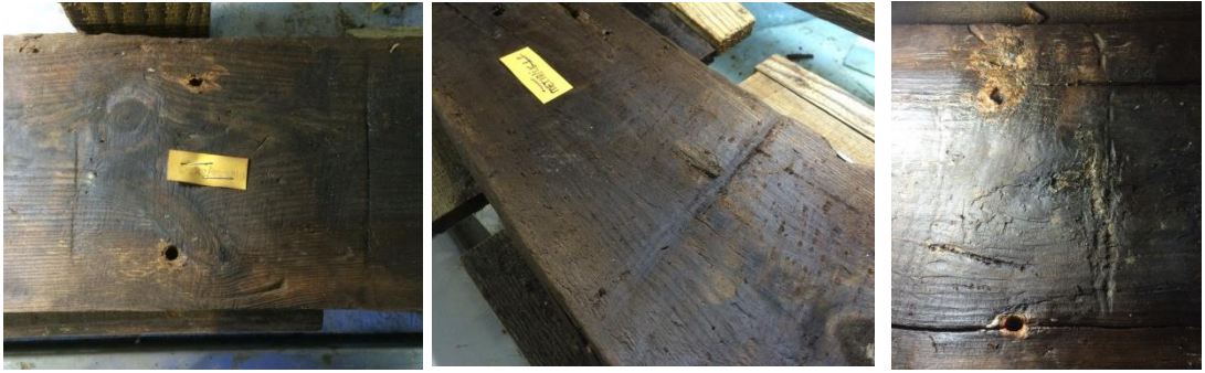
Şekil 48: Kaplama yüzeylerindeki marangoz işaretleri (soldan sağa; SK3-3, İK1-2, SK6-3)
