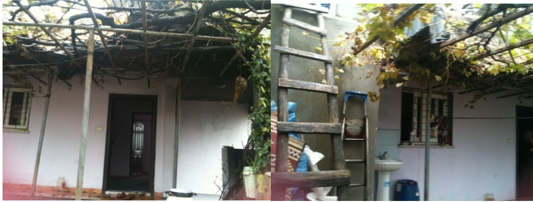
Şekil 4.74. Mıntıka 4 Parsel 2648'de bulunan bina ve kayıt alma işlemi
