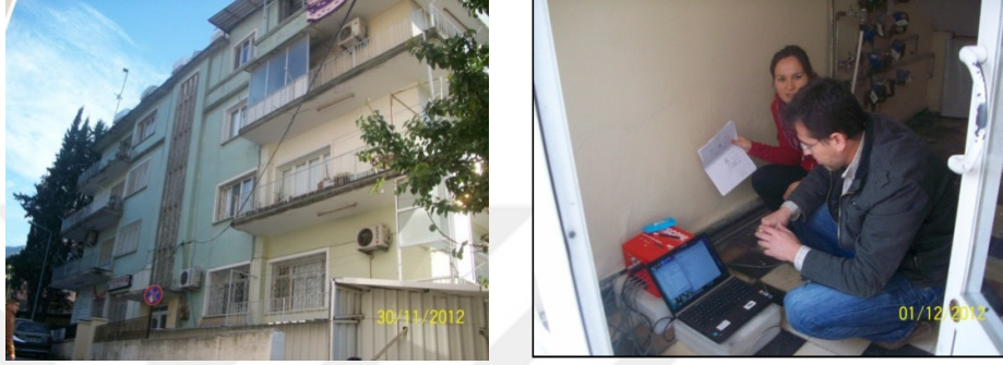
Şekil 4.8. Mıntıka 2, Parsel 811'de bulunan bina ve kayıt alma işlemi
