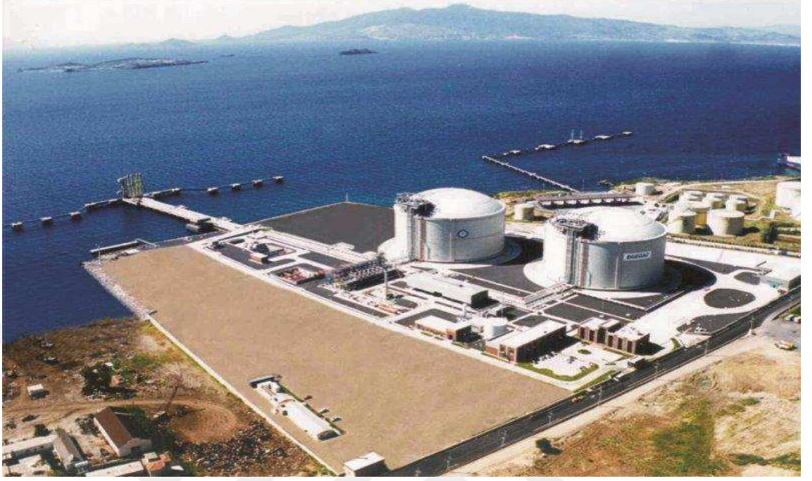
Şekil 4.37. İzmir Egegaz Aliğa LNG Terminali
