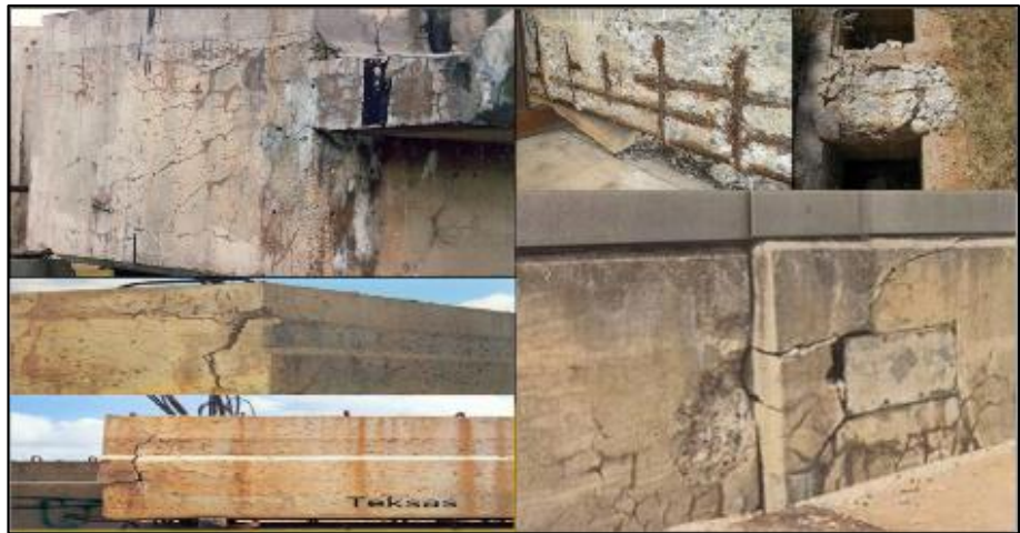
Şekil 3.16. Beton malzemenin zamanla donma-çözünme sonucu tahribatı
