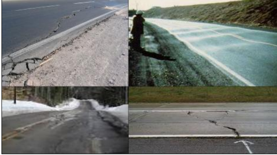
Şekil 3.15. Şişen zeminlerin oluşturduğu ve donma-çözünmenin verdiği zararlar
