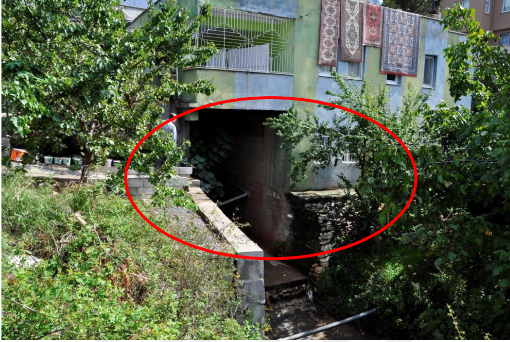
Resim 4.2. Belen ilçesinden geçen Belen Deresi üzerinde yapılan bina
