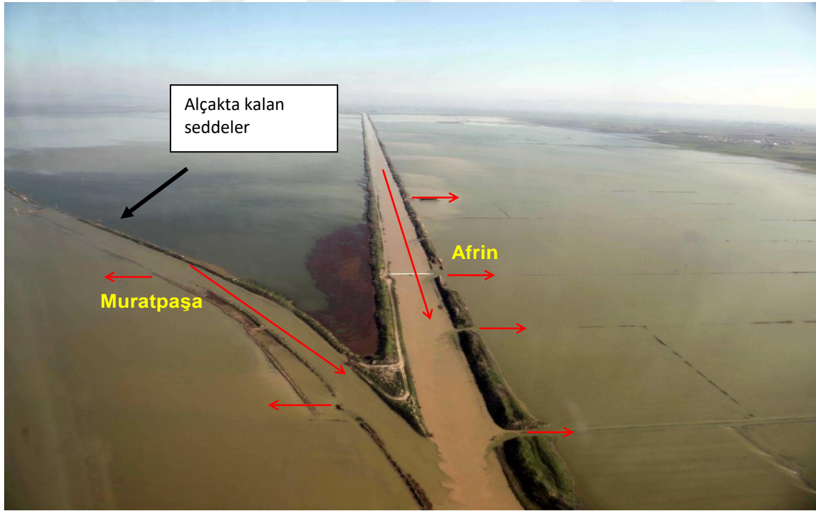
Resim 4.62. Sedde kret kotlarının alçakta olması
