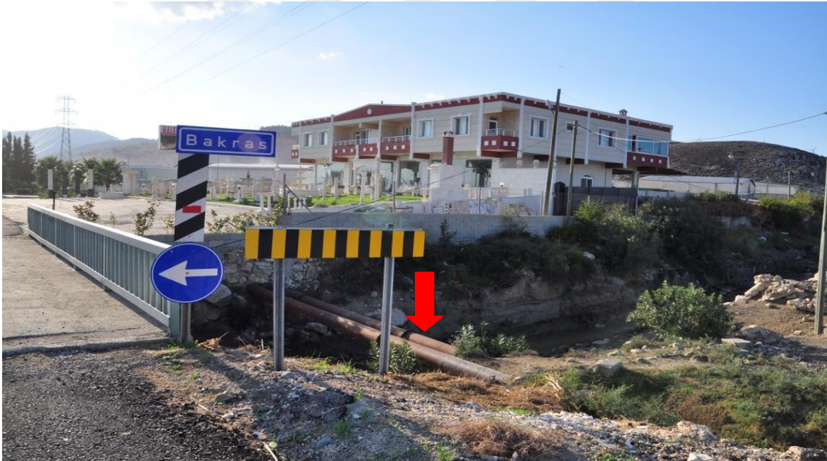
Resim 4.30. Belen ilçesi Ötençay Deresi üzerinde kesiti daraltan içme suyu borusu
