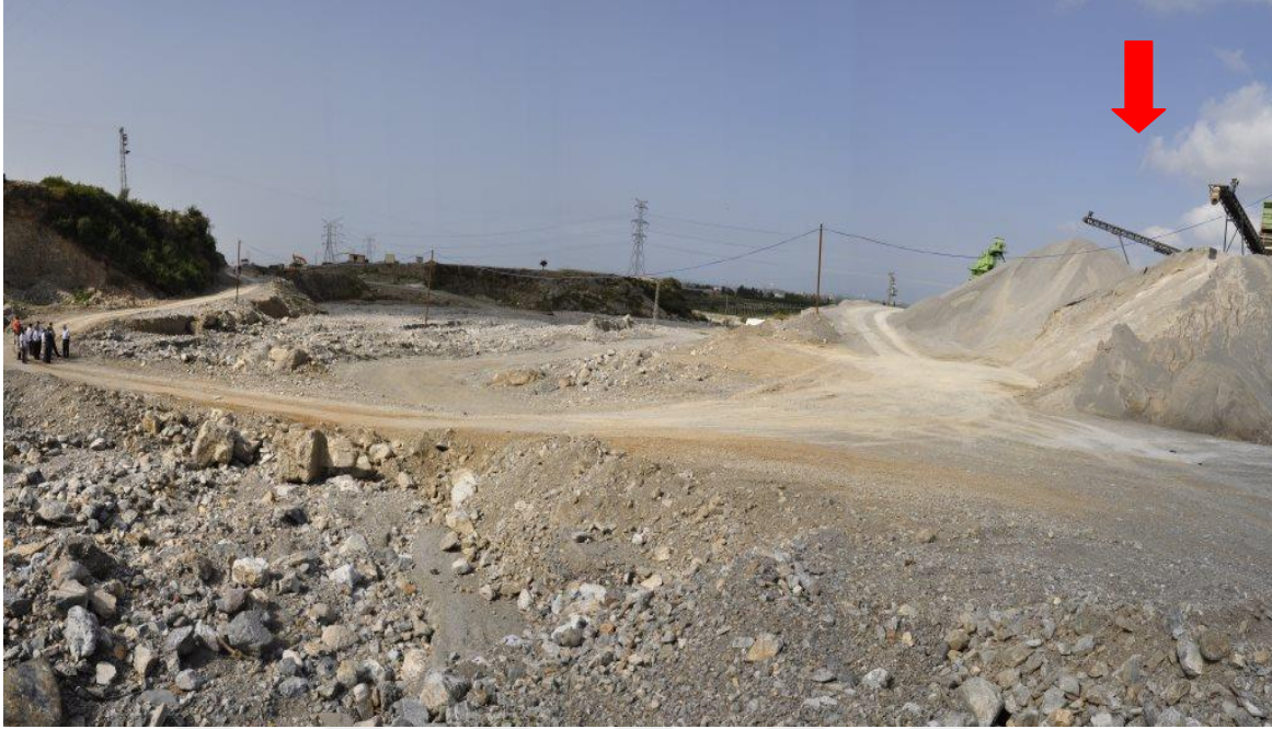
Resim 4.35. Payas ilçesi Çağlalık mahallesinde bulunan kuru deresindeki kum ocağı
