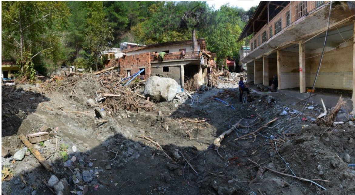
Resim 4.60. Erzincan ilesi İmeler mevkiinde afet sonrası yerleim yerlerinin durumu
