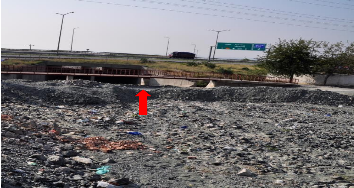
Resim 4.32. Arsuz ilçesi Abuzed Deresi üzerinde kesiti daraltan yaya köprüsü
