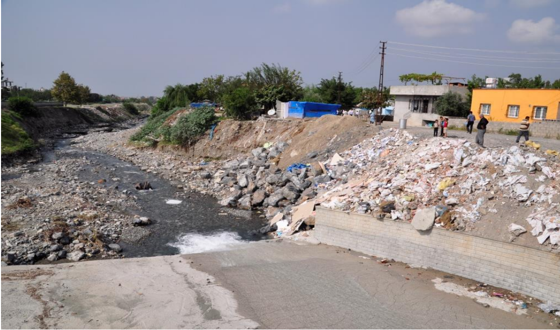
Resim 4.8. Dört Yol ilçesinde Özerli Deresi kesiti içerisinde atılan molozlar ile kesit daraltılması
