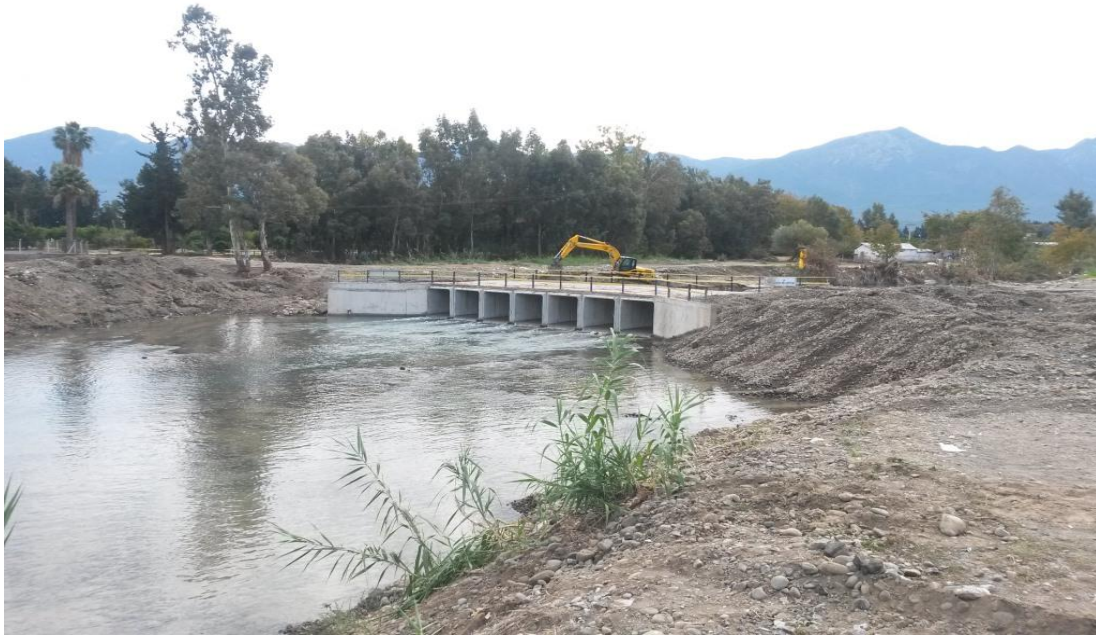
Resim 4.18. Arsu ilçesi Uluçınar Deresi üzerinde kesiti daraltan sanat yapısı
