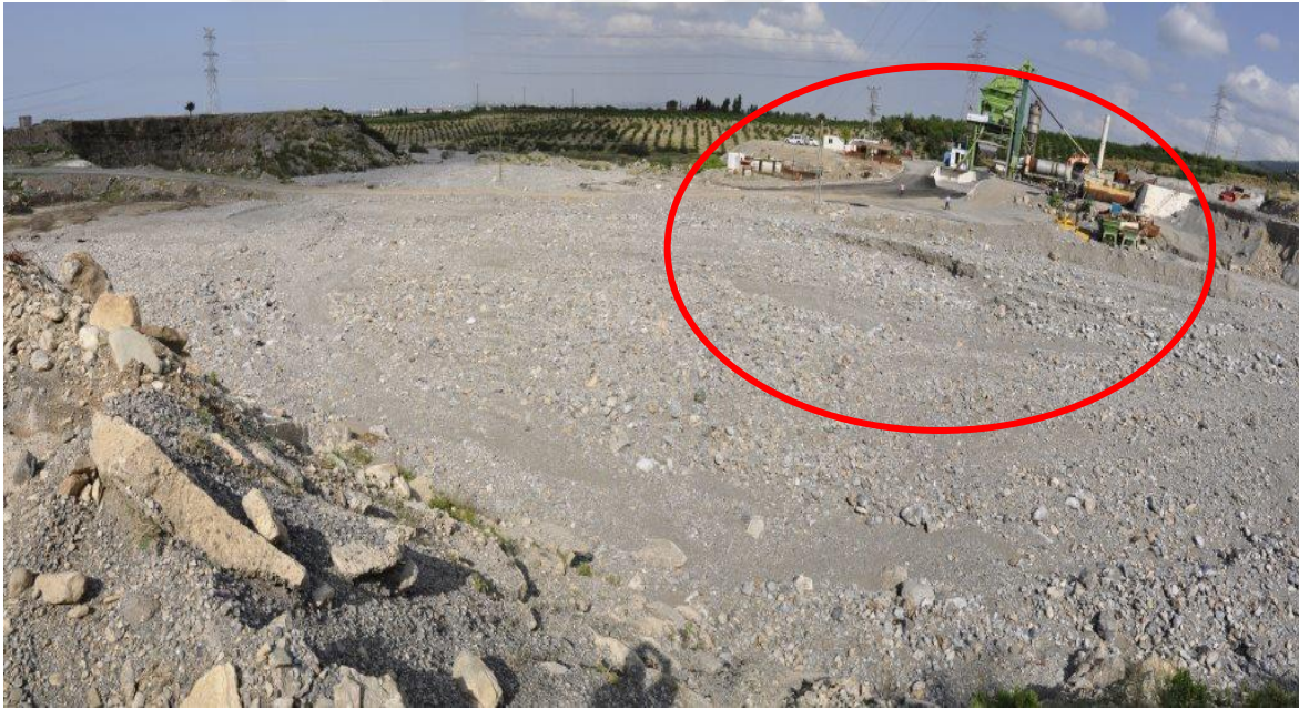
Resim 4.34. Payas ilçesi Çağlalık mahallesinde bulunan kuru deresi içerisinde asfalt şantiyesi, kum ocağı ve taş ocağı
