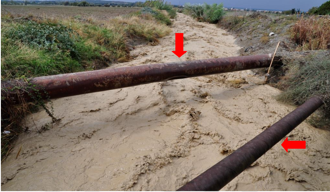
Resim 4.29. Arsuз ilçesi Madenli Deresi taşkın anındaki durumu
