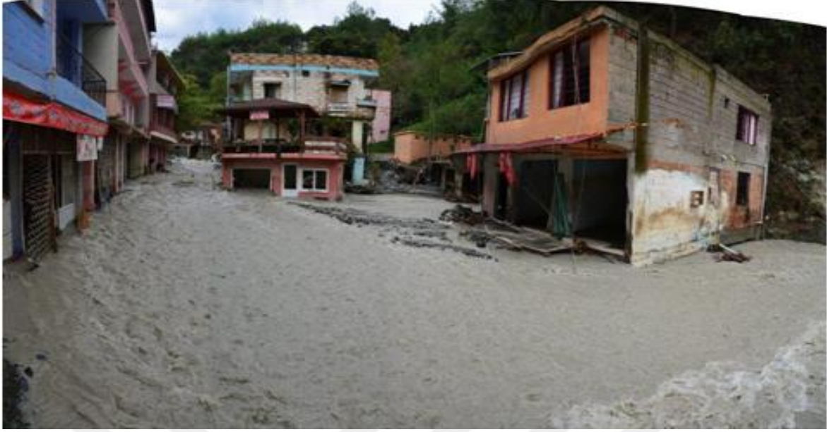
Resim 4.59. Erzincan ilesi İmeler mevkiinde afet sonrası iyerlerinin durumu
