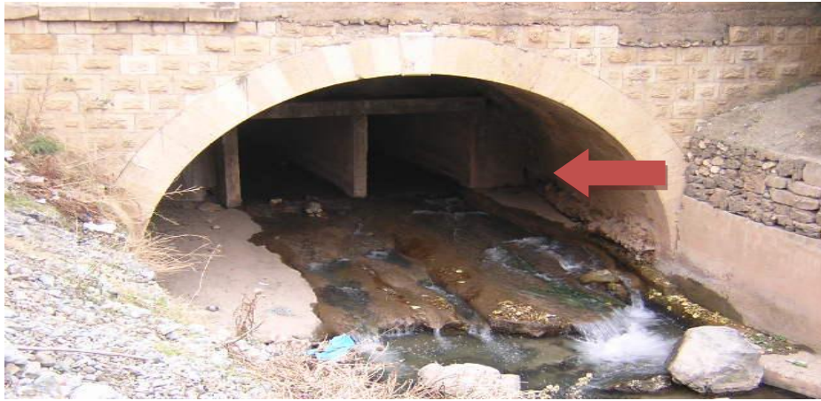
Resim 4.16. Kırıkhan İlçesi Delibekirli Deresi tarihi köprüye müdahale
