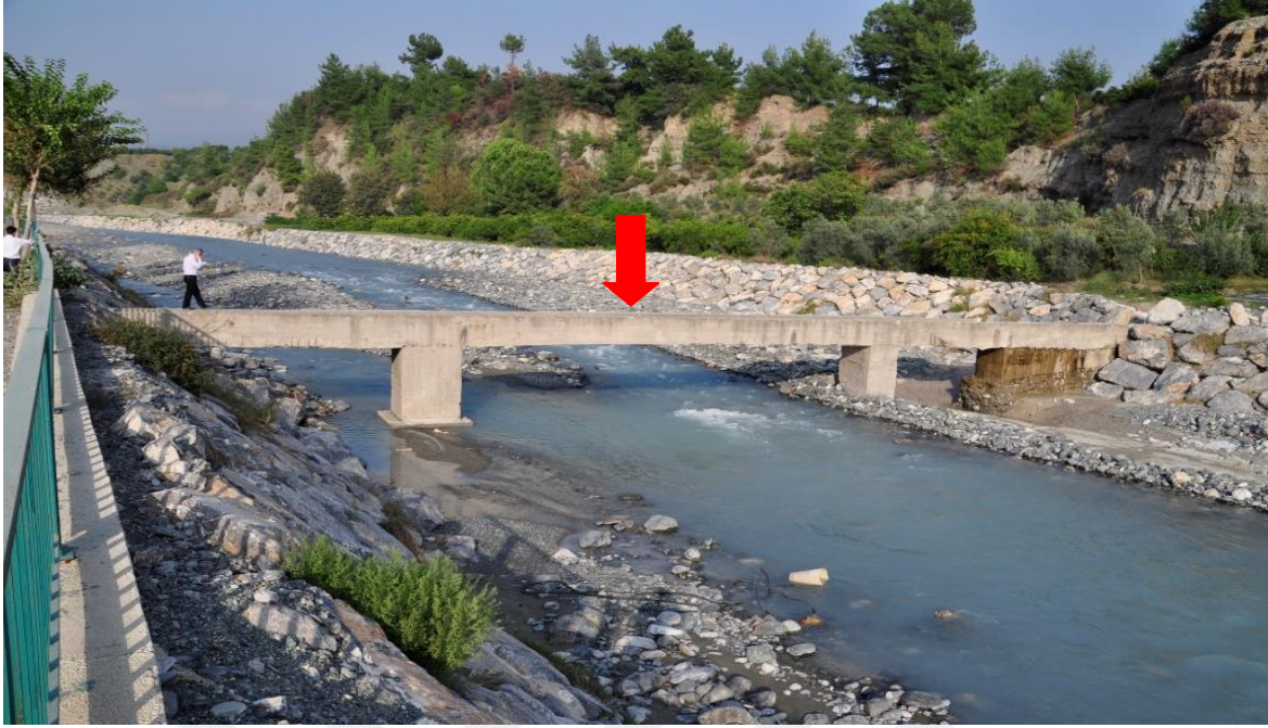
Resim 4.31. Dörtüyl ilçesi Deliçay Deresi üzerinde kesiti daraltan sulama kanalı
