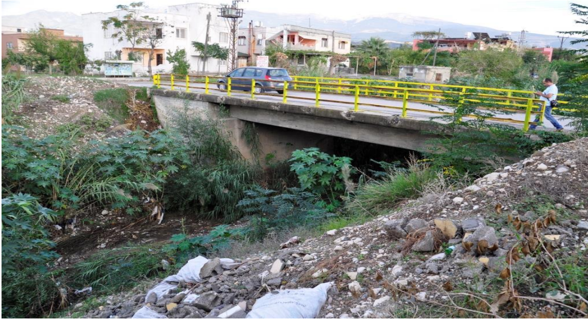
Resim 4.21. Arsuz Şekere Deresi üzerinde kesiti yetersiz köprü
