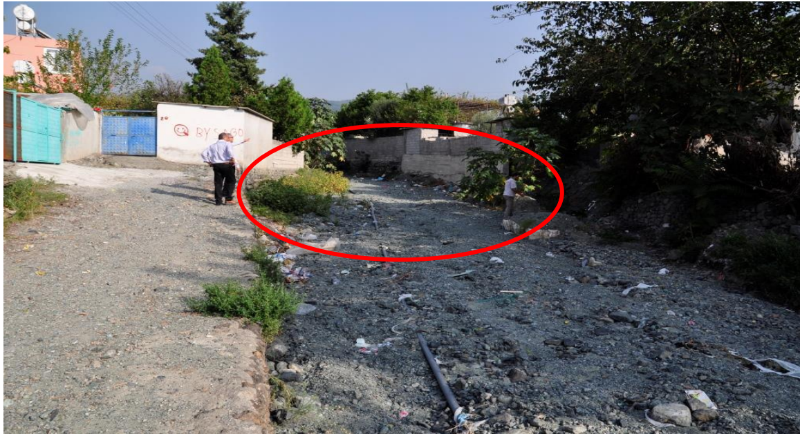
Resim 4.4. Arsuz ilçesi Abuzed Deresi üzerinde yapılan binalar
