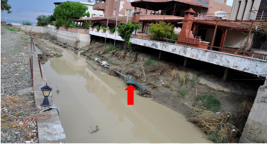
Resim 4.38. Arsuз ilçesi Sođanlık Deresi boyunca mevcut kesit içindeki yapılaşmalar
