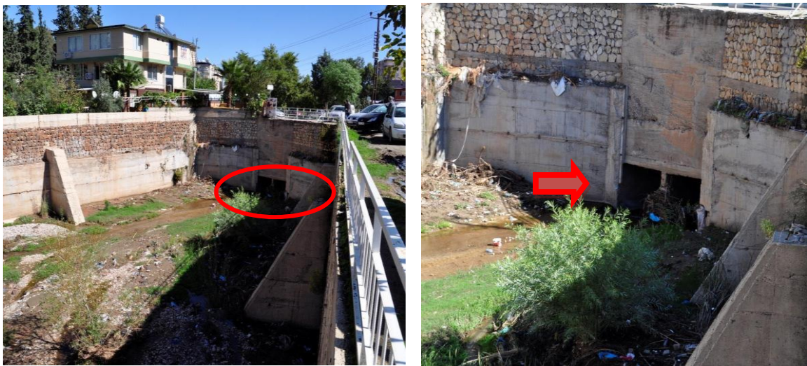
Resim 4.17. Menfezin memba kısmından yetersiz kesitte ve iki gözlü olması
