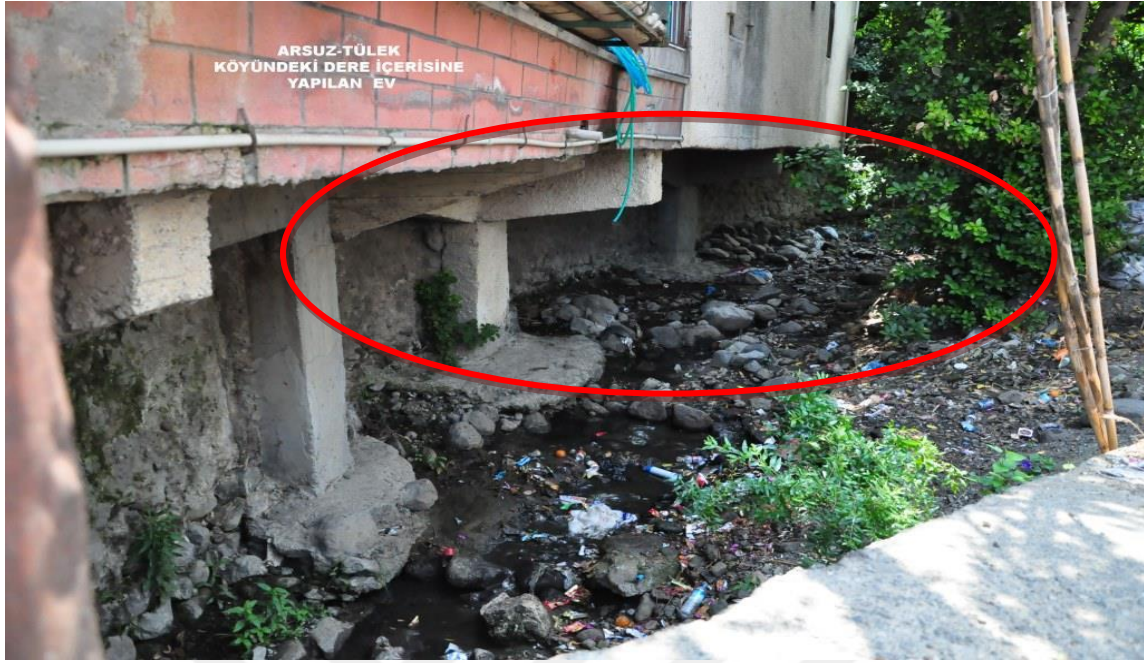
Resim 4.5. Arsuz ilçesi Tülek Deresi üzerinde yapılan ev
