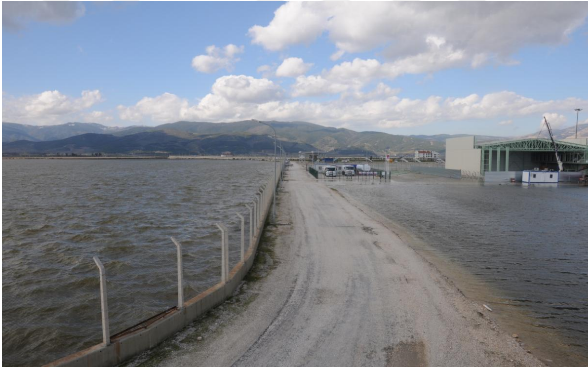
Resim 4.61. Havaalanı çevre duvarı
