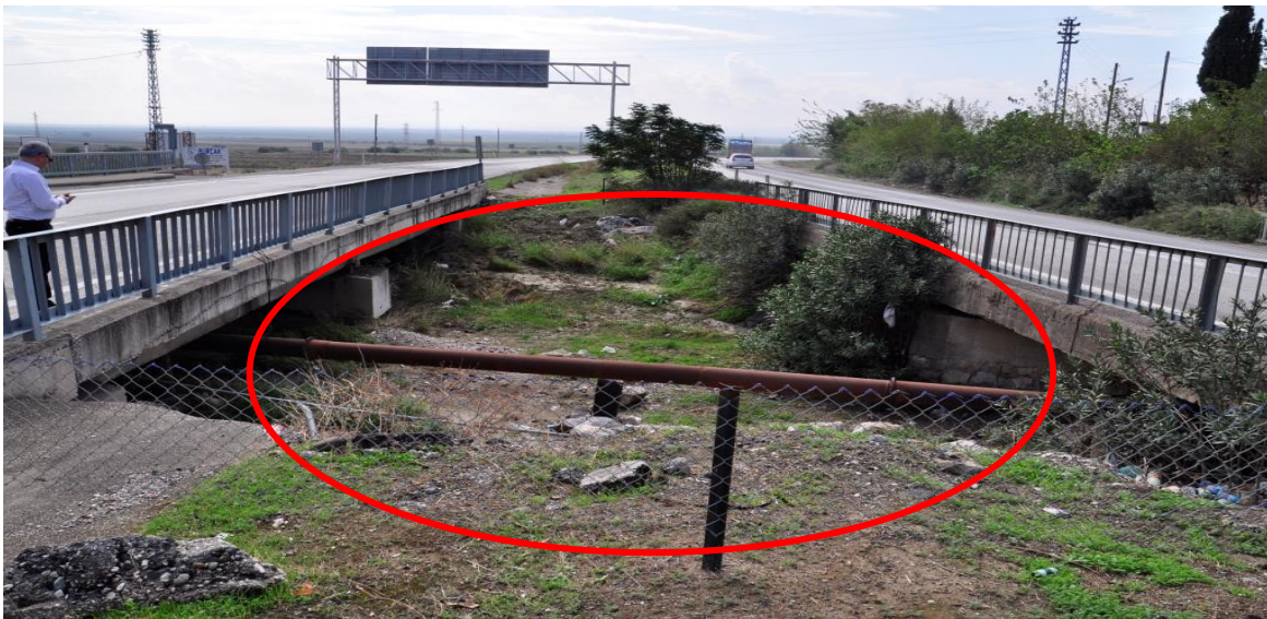
Resim 4.51. Antakya ilçesi Topboğazı mıntıkasında dere yatağının giriş ve çıkışı temizlik yapılmadığı için kesit daralması
