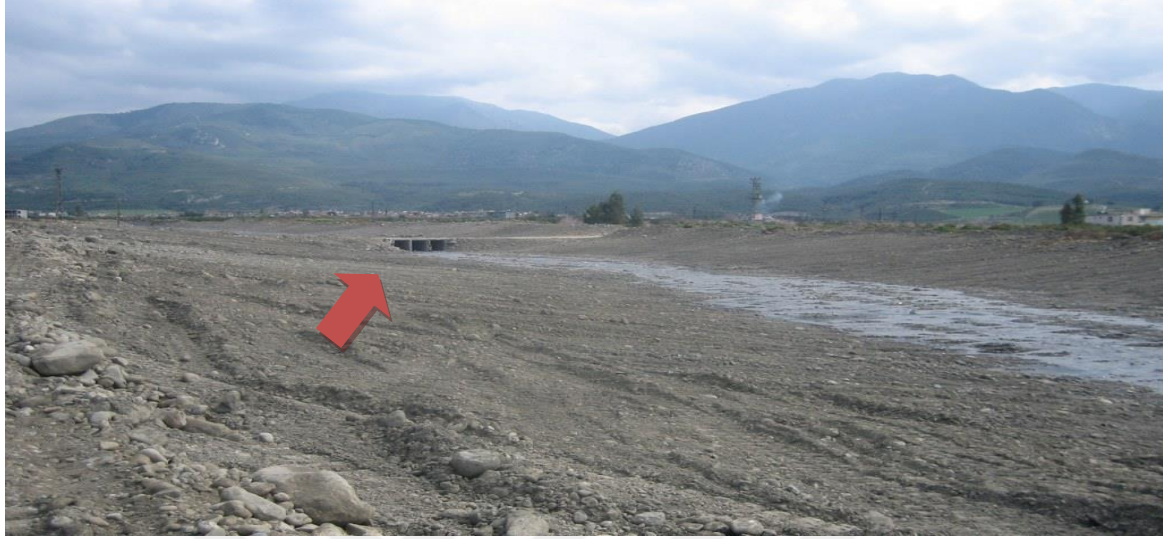
Resim 4.19. Arsuз ilçesi Hacıahmetli Mahallesi kesiti yetersiz köprü
