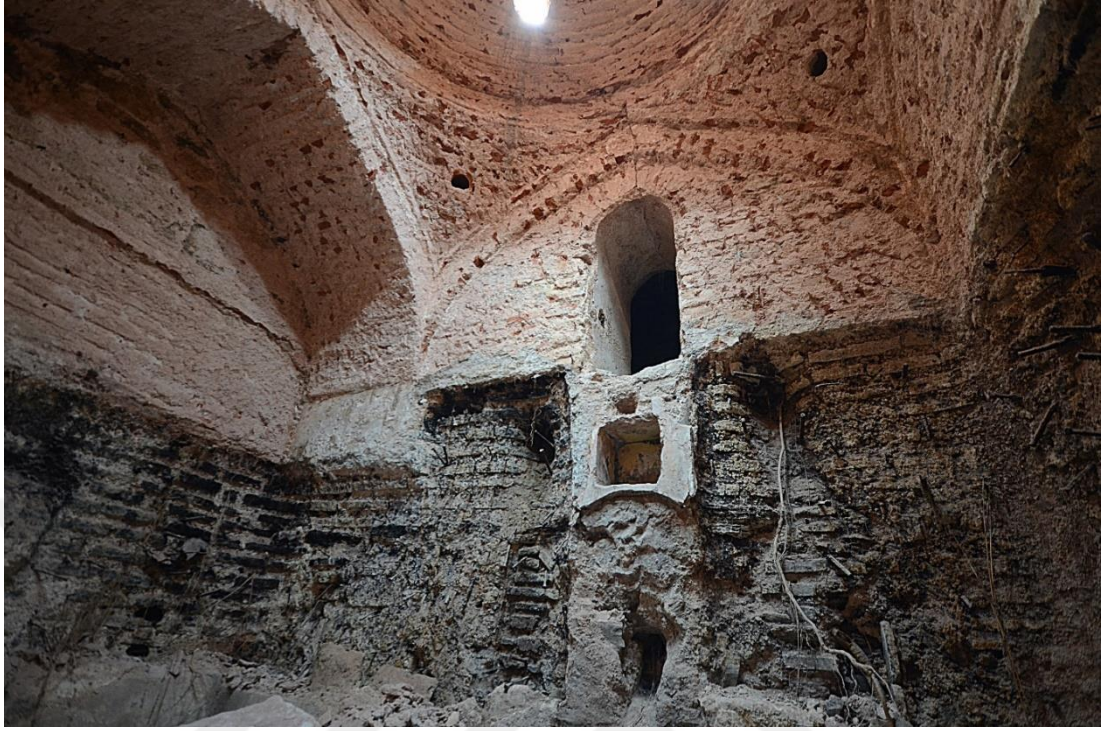
Fotoğraf 20. Darüşşifa Hamamı İç Görünüm
